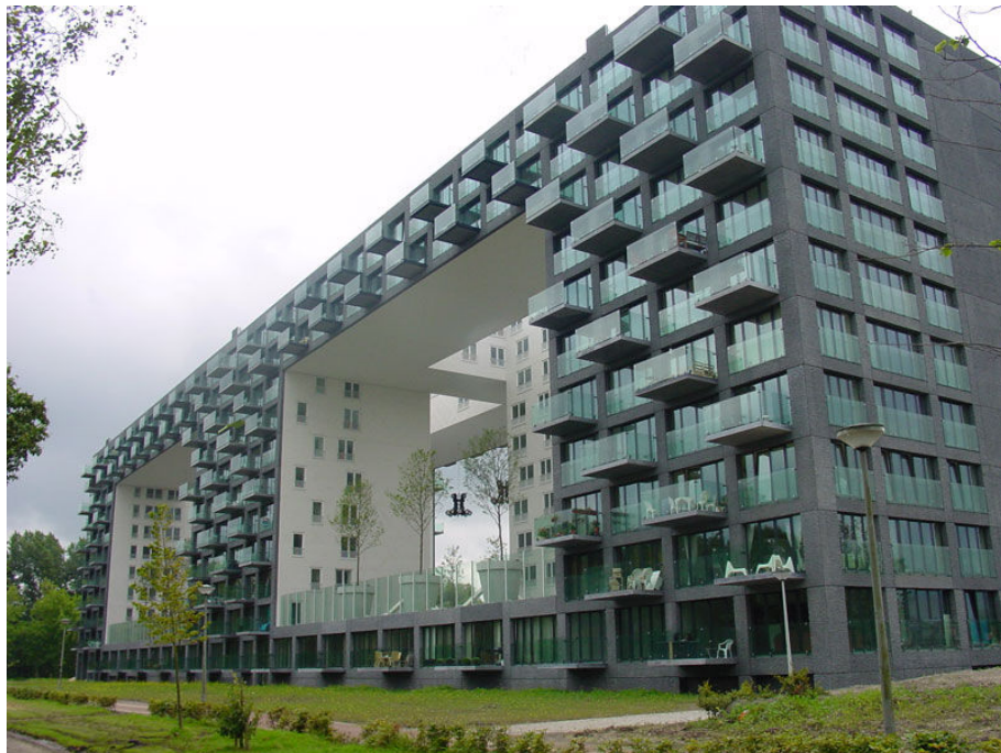
Figura 115: Vista geral externa (DESIGNWS, 2010).
