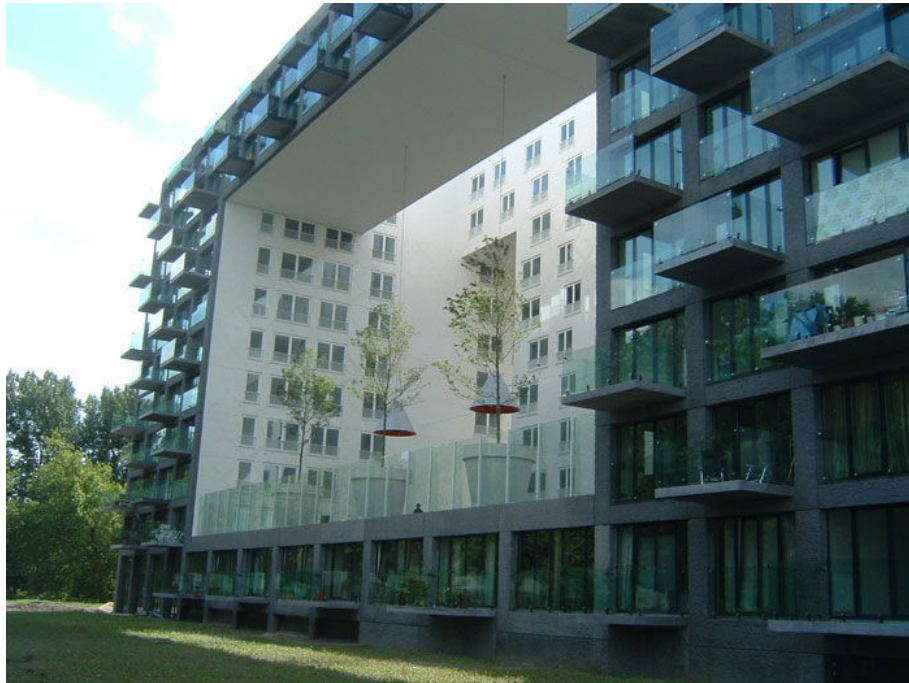
Figura 116: Vista geral externa (DESIGNWS, 2010).
