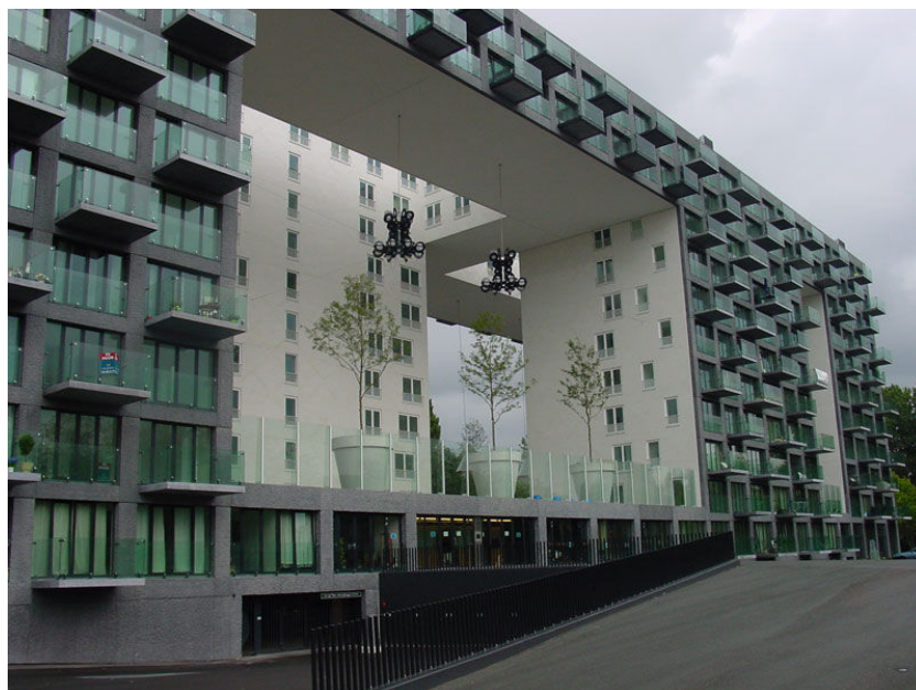
Figura 117: Vista geral externa (DESIGNWS, 2010).
