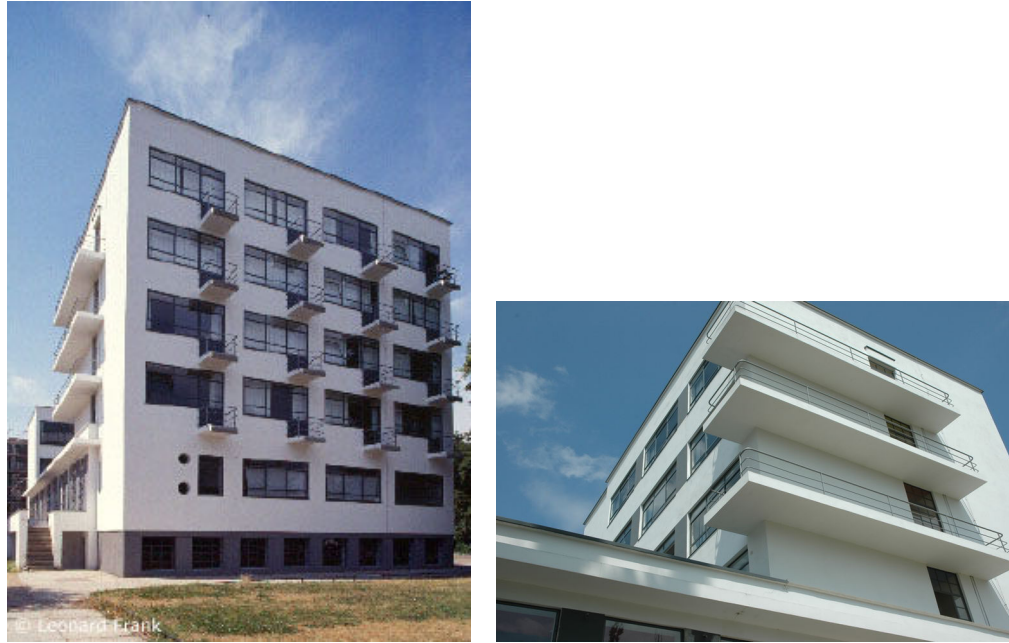
Figura 42 e 43: Vista externa da Bauhaus (BAUHAUS, 2010)
