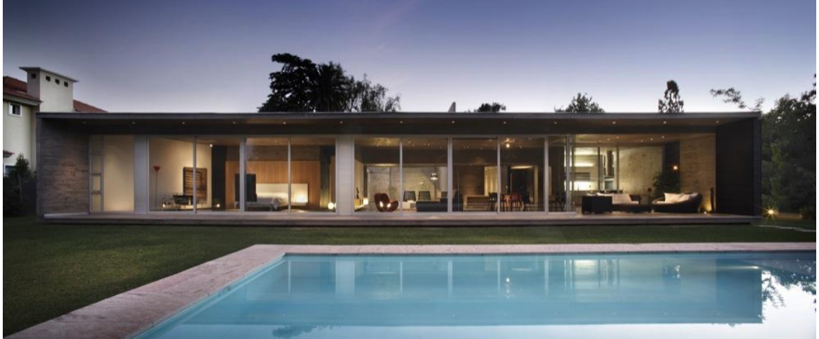
Figura 5.9 – Detalhe dos vãos das esquadrias que acentuam a horizontalidade do projeto (PASTORELLI, 2010).
