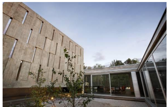
Figuras 5.10 e 5.11 – Detalhe do muro de concreto que tem como função proteger a residência da radiação solar (PASTORELLI, 2010).
