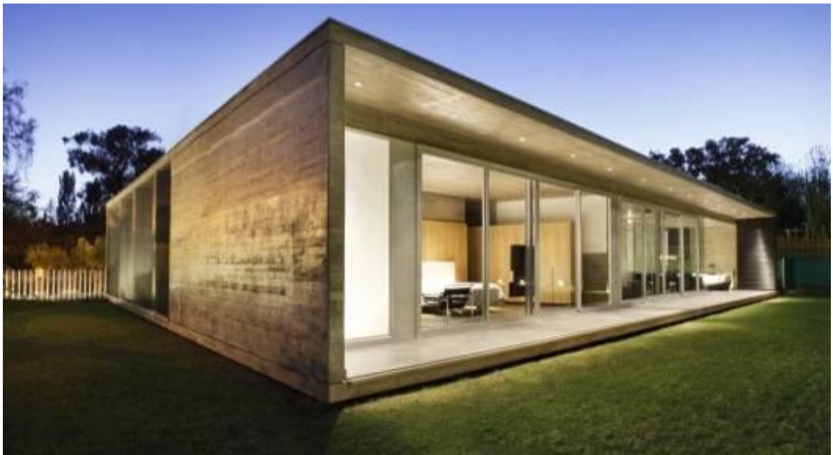
Figura 5.8 – Vista geral da edificação (PASTORELLI, 2010).
