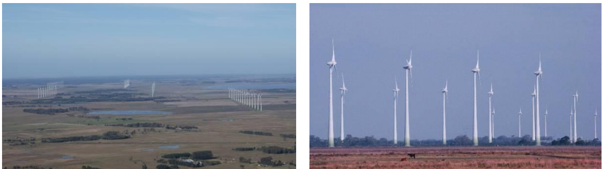
Figuras 1.18 e 1.19 – Parque Eólico de Osório (PREFEITURA DE OSÓRIO, 2010).
