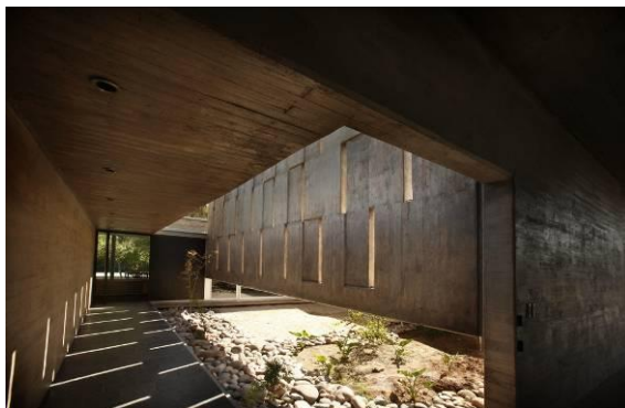
Figuras 5.10 e 5.11 – Detalhe do muro de concreto que tem como função proteger a residência da radiação solar (PASTORELLI, 2010).
