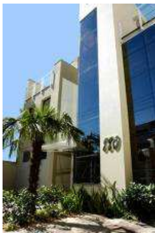
Imagem 13 – Vista Externa da Clínica PlastiCare Fonte: PLASTICARE, 2010.
