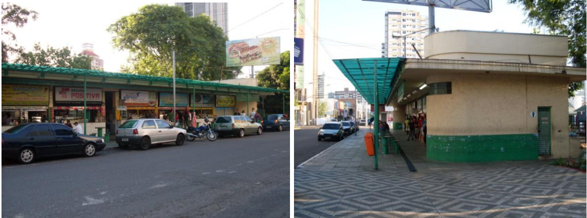
Figuras 31 e 32: O prédio das bancas em seu estado atual Fonte: AUTORA; 2010.
