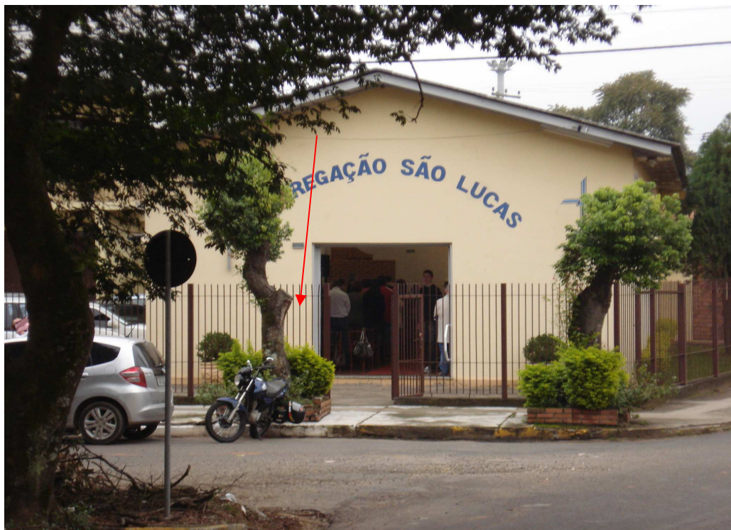
Imagem 41: Acesso principal da igreja Fonte: Autor (2010).
