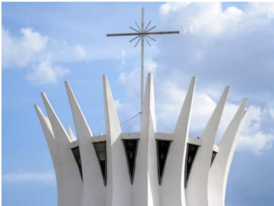
Imagem 21: Cobertura apoiada pelos 16 pilares de concreto armado Fonte: Multiply (2010).
