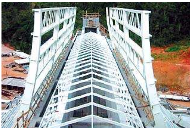
Imagem 79: Montagem da estrutura metálica e vidro no centro da cobertura Fonte: Arcoweb (2010).
