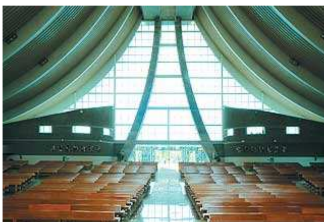
Imagem 77: Duas vigas centrais de concreto ficam a 28m de altura do piso da nave Fonte: Arcoweb (2010).
