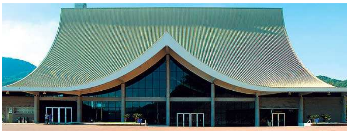
Imagem 78: Vista lateral com paredes de vidro e cobertura metálica Fonte: Arcoweb (2010).
