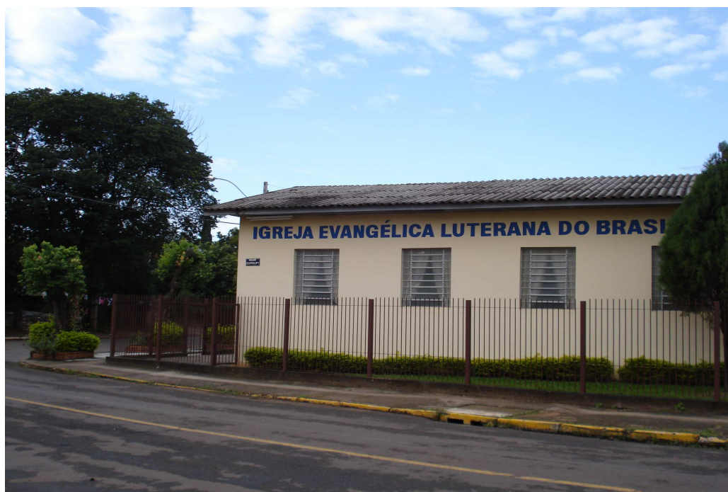
Imagem 42: Fachada norte junto a Rua Guanupi Fonte: Autor (2010).
