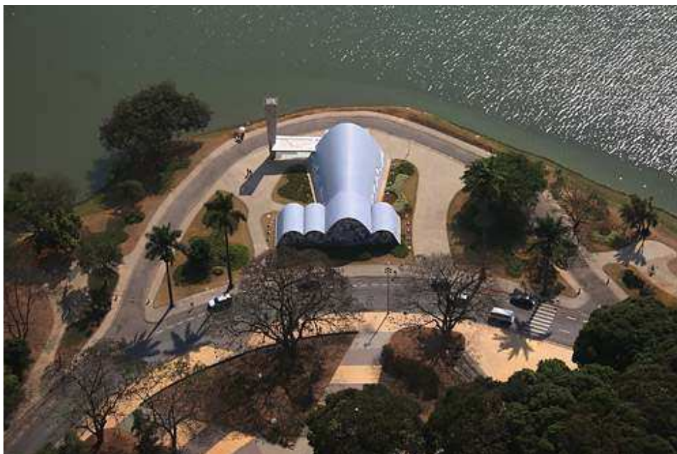
Imagem 13: Vista aérea da capela junto ao lago artificial da Pampulha Fonte: UFMS (2010).
