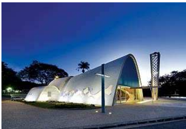
Imagem 8: Cobertura de concreto armado Fonte: Arcoweb (2010).
