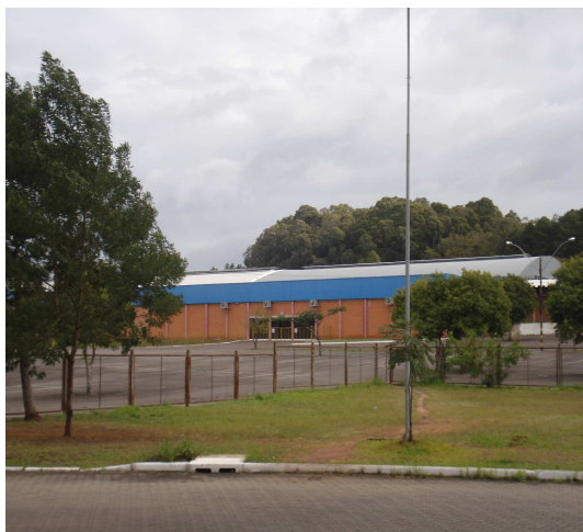
Imagem 59: Pavilhões da FENAC Fonte: Autor (2010).
