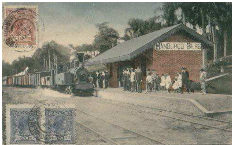
Imagem 50: Estação de trem Hamburg Berg Fonte: Estação Ferroviária do Brasil (2010).
