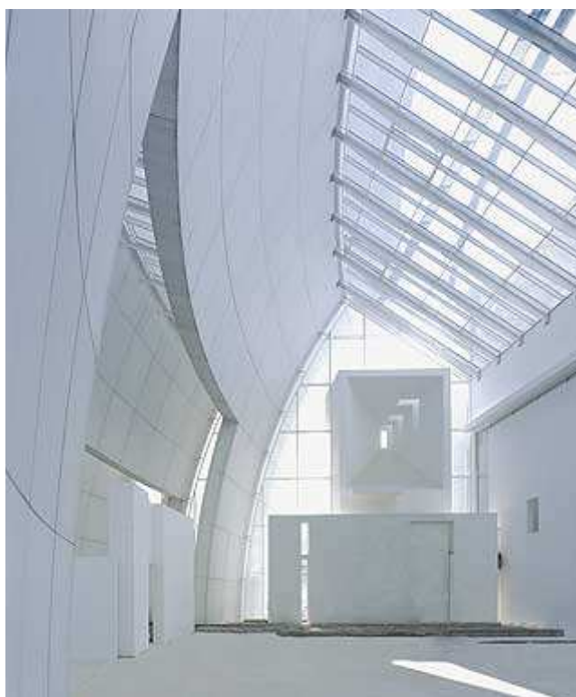
Imagem 73: Cobertura de vidro Fonte: Arcoweb (2010).
