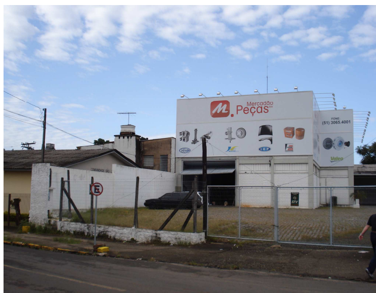
Imagem 65: Pavilhão de auto peças Fonte: Autor (2010).
