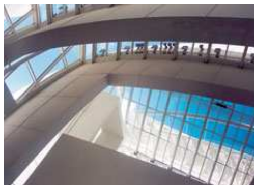
Imagem 33: Cobertura de vidro Fonte: Arcoweb (2010).
