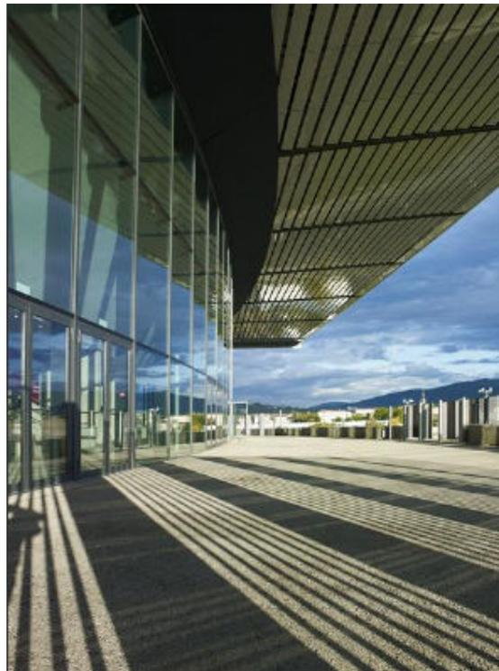
**Figura 87 – Imagem: Fachada com vidros e brises**
