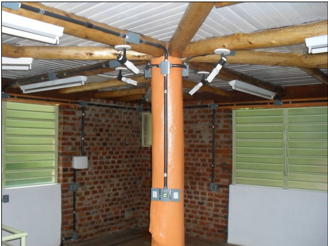
Imagem 39 – Laboratório de Informática – em construção
