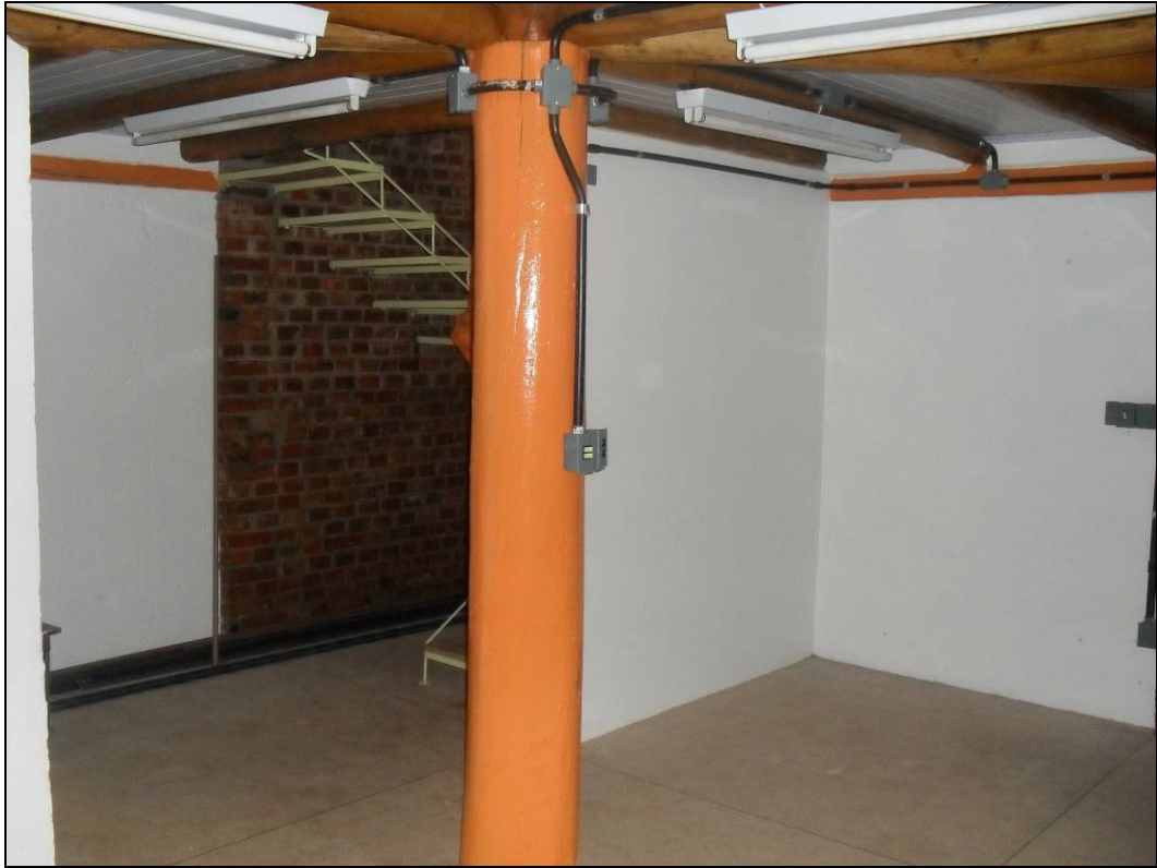
Imagem 38 – Biblioteca – em construção
