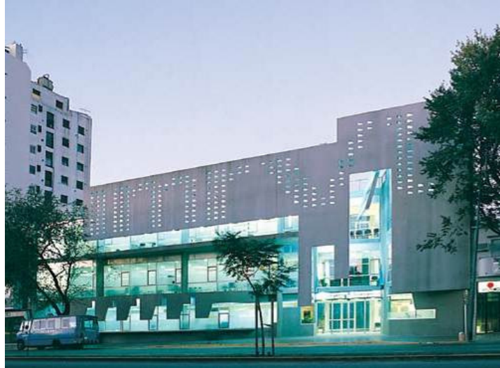
Imagem 5.3 – Paineis pré-moldados de concreto perfurado (ESMORIS, 2005).
