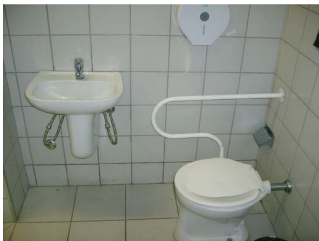
Imagem 3.30 - Banheiro adaptado – barras de apoio (KLEIN, 2008).
