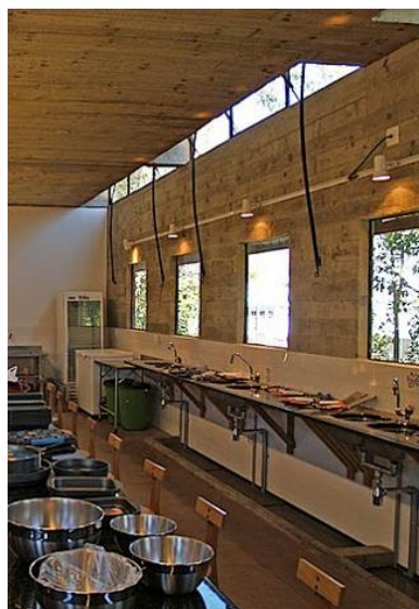
Imagens 6.10 – Sistema de ventilação (MAHFUS, 2008).
