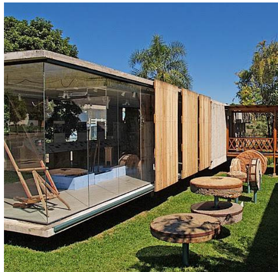
Imagens 6.09 – Placas de concreto e painéis móveis de madeira (MAHFUS, 2008).
