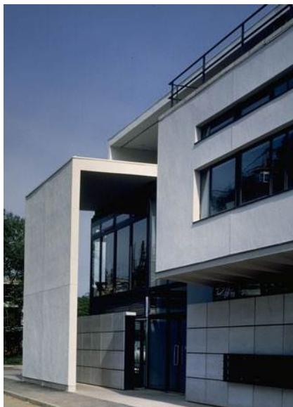
Imagem 6.5 – Vista lateral, marquise (HODDER ASSOCIATES, 2009).
