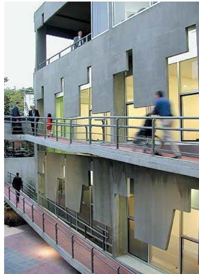
Imagem 5.4 – Detalhes na fachada e rampas (ESMORIS, 2005)
