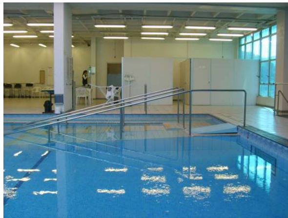
Imagem 3.24 - Rampa de acesso à piscina (KLEIN, 2008).
