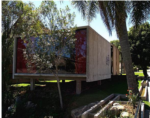
Imagens 6.8 – Estrutura de concreto e fechamento de vidro (MAHFUS, 2008).
