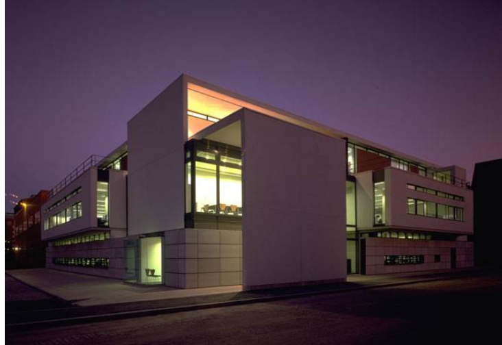
Imagem 6.6 - Vista geral do conjunto (HODDER ASSOCIATES, 2009).
