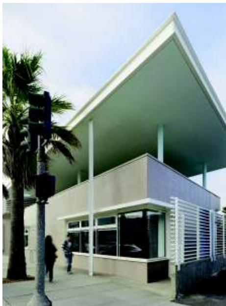
Figura 2.17 – detalhe do sobre-telhado (FLETCHER, 2009).
