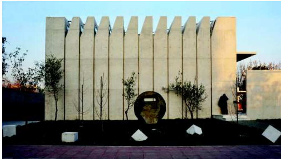
Figura 5.6 - Fachada Sul (EGUIGUREN, 2008)
