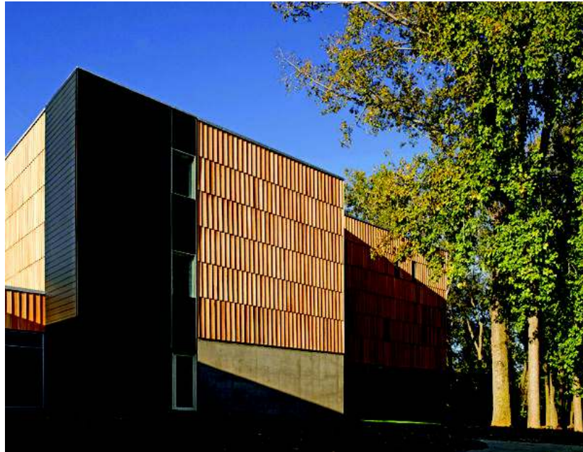
Figura 2.12 – Fachada posterior da biblioteca (PERREAULT, 2010).
