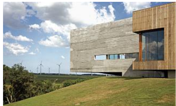
Figura 5.4 – Acesso através de galeria semiaberta; Figura 5.5 – Detalhe dos painéis verticais de madeira e painéis de concreto com ranhuras horizontais (ARCOWEB, 2010).
