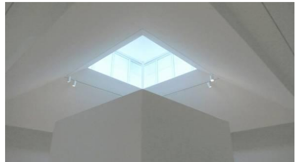
Figuras 5.23 – Vista interna do museu com aplicação de protetores solares na parte externa da fachada; Figura 5.24 – Vista da claraboia para iluminação das galerias (BASULTO, 2010).
