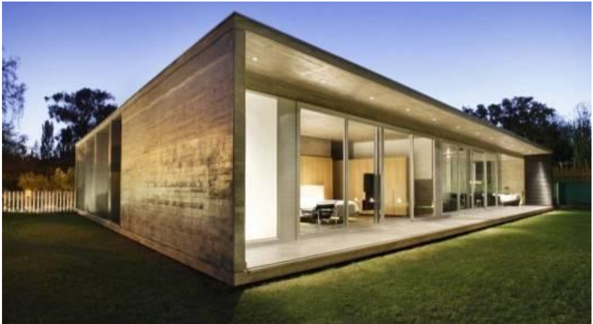
Figura 5.8 – Vista geral da edificação (PASTORELLI, 2010).
