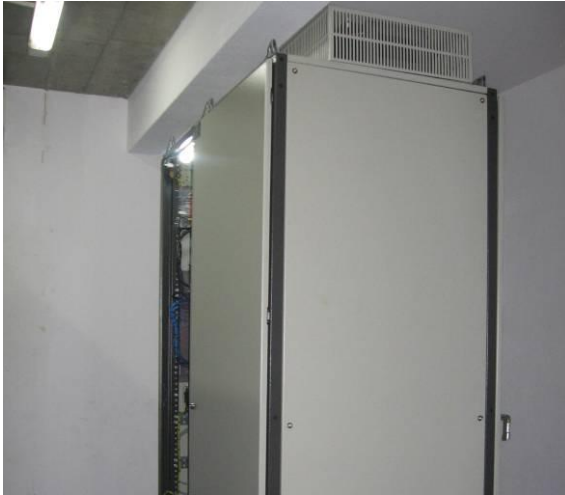
Figura 4.3 – Gerador de energia; Figura 4.4 – Equipamento de controle do funcionamento do teleférico (AUTOR, 2010).
