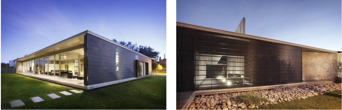
Figuras 5.12 e 5.13 – Detalhe do fechamento da fachada com chapas de alumínio microperfuradas na cor preta (PASTORELLI, 2010).
