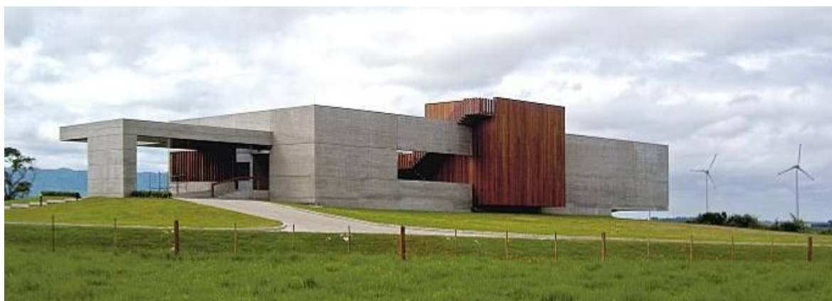
Figura 5.1 – Vista geral da edificação com destaque para o mirante localizado sobre o volume revestido de madeira (ARCOWEB, 2010).
