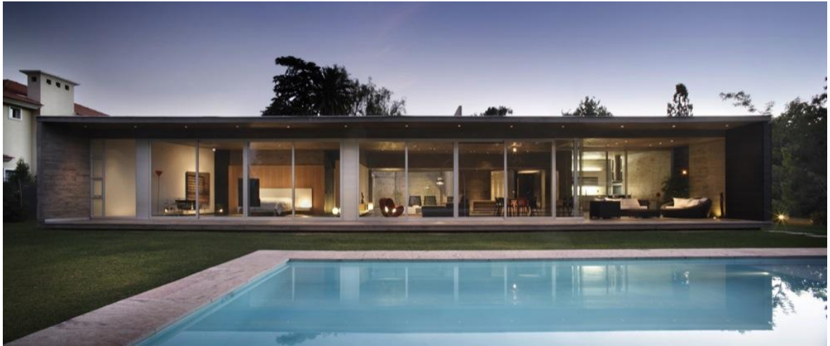
Figura 5.9 – Detalhe dos vãos das esquadrias que acentuam a horizontalidade do projeto (PASTORELLI, 2010).
