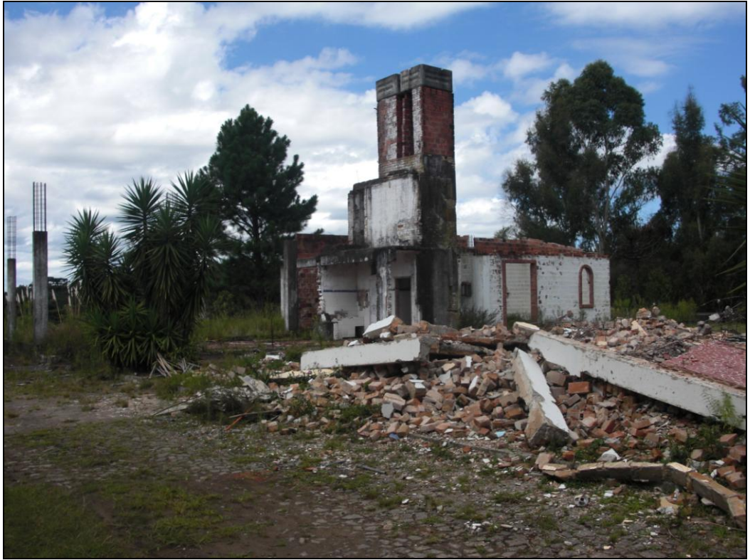
Foto 3 – Edificação no lote. Situação atual é de ruína.
