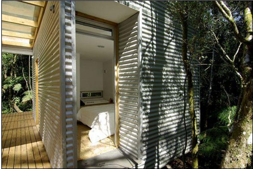
Imagem 51 – Detalhe para chapa ondulada utilizada como revestimento externo.
