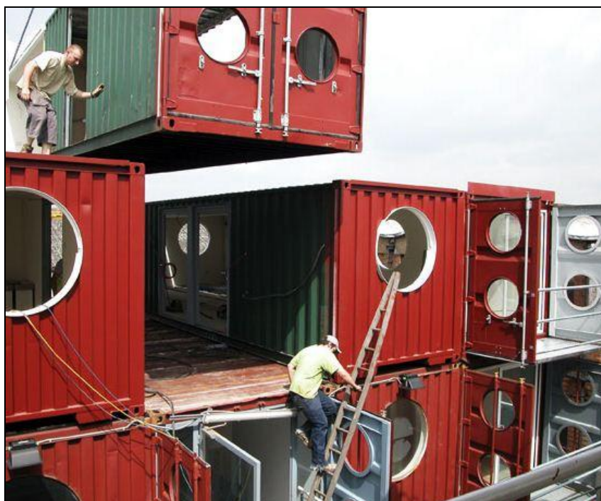
Imagem 33 – Montagem da modulação. Fonte: Urban Space, 2010
