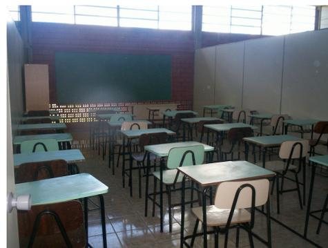
Foto 2: Iluminação natural inadequada e divisórias que não permitem o isolamento acústico
