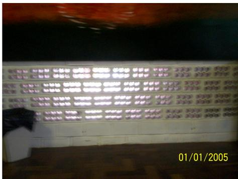
Foto 18: Paredes externas. Furações dos tijolos permitem a entrada de ar
