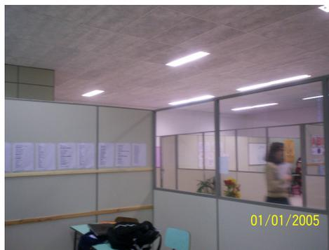
Foto 13: Falta de isolamento acústico entre os ambientes
