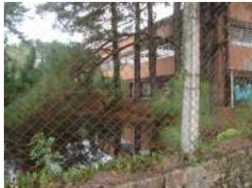
Imagem 5.20: Vista lateral prédio existente
