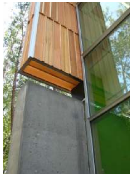
Imagem 3.23: Detalhe 2 da fachada recuada (CONCURSOS DE PROJETO, 2010a)
