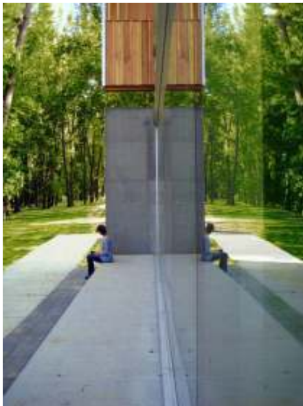
Imagem 3.22: Detalhe da fachada recuada (CONCURSOS DE PROJETO, 2010a)
