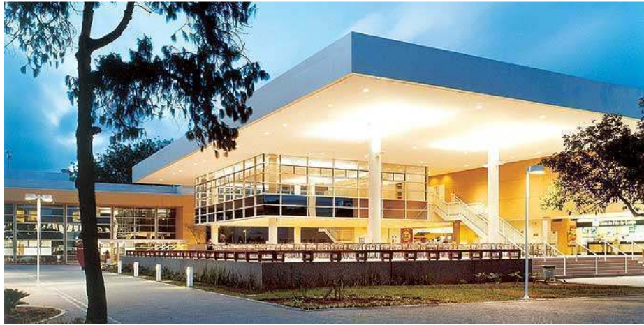
Imagem 7.5: Fachada (ARCOWEB, 2010C)
