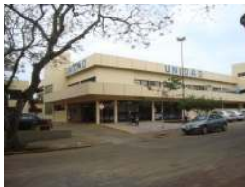
Imagem 5.10: Supermercado, esquina Av. Antão de Farias e Rua Santo Antônio
