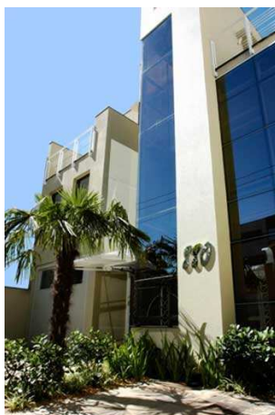
Imagem 13 – Vista Externa da Clínica PlastiCare Fonte: PLASTICARE, 2010.
