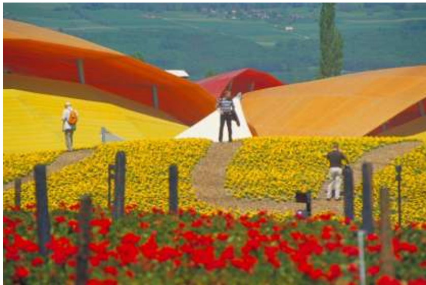
Imagem 105: Pavilhões de exposição se mesclam a topografia do terreno
