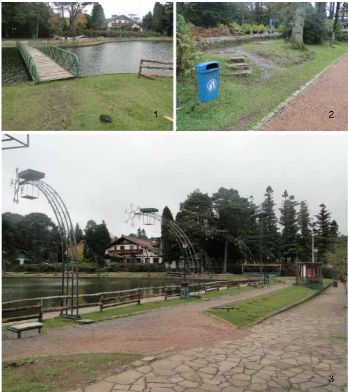
Imagem 58: O calçamento do passeio encontra-se mal conservado
