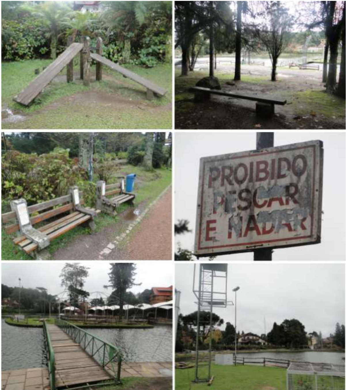
Imagem 60: Equipamentos urbanos encontrados no parque: brinquedos, bancos, placas informativas, ponte e iluminação pública, todos em péssimo estado de conservação
