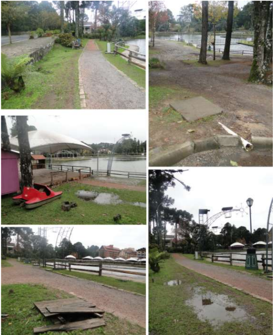
Imagem 59: Aparência de descuido, problemas na drenagem e caixas de passagem de rede elétrica
