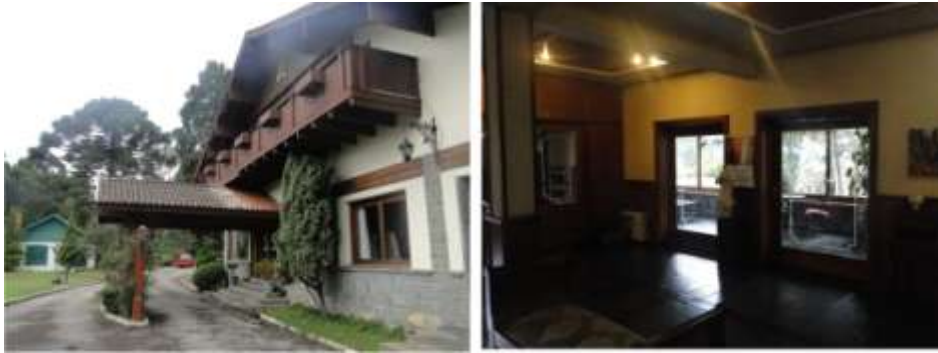
Imagem 73: Prédio principal do antigo Hotel, atual centro de cultura de Gramado
