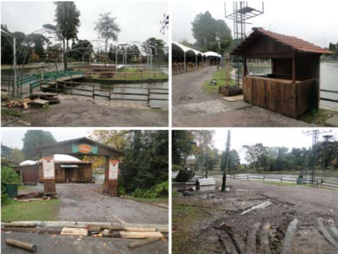
Imagem 63: Bilheteria e estruturas provisórias. Falta de acesso aos veículos de carga, terreno danificado a cada novo evento
