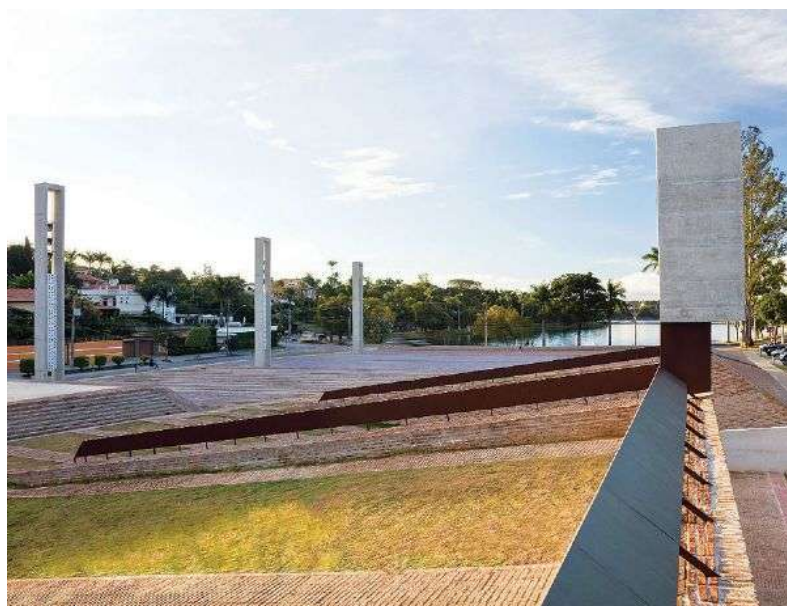
Imagem 114: Vista geral da praça sobre arquibancada
