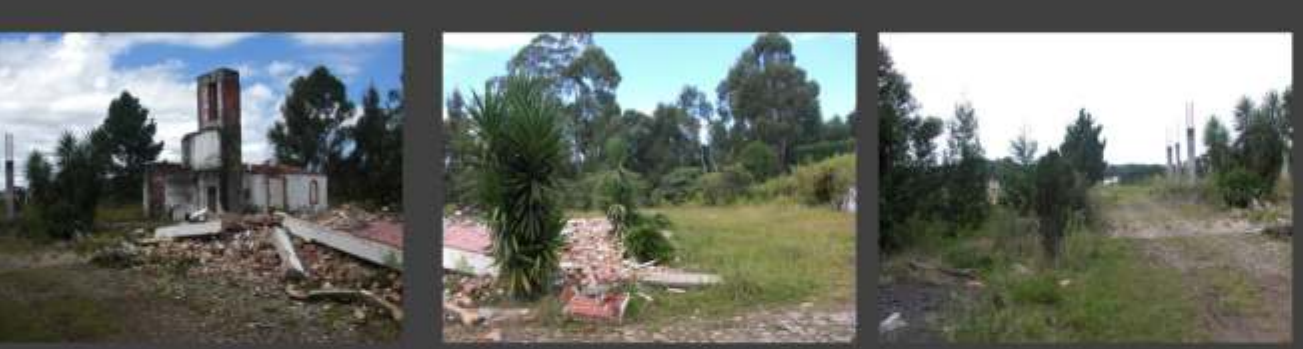
FOTOS 2,3 E 4 NA SEQUÊNCIA - EDIFICAÇÃO NO LOTE. SITUAÇÃO ATUAL É DE RUÍNA.
