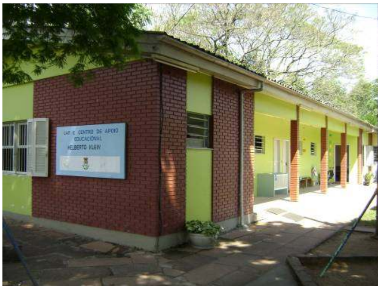
Imagem 1.4.8: Vista lateral dos quartos e ao fundo a porta da cozinha. Fonte: Autora, 09/2010
