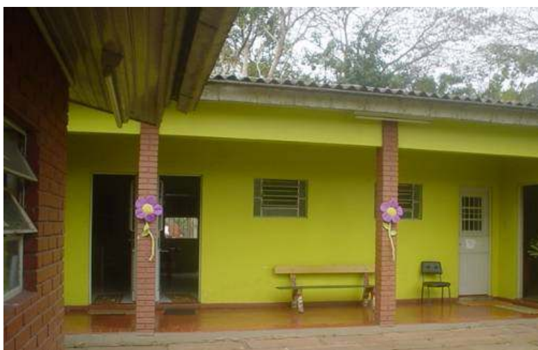
Imagem 1.4.9: Vista frontal dos quartos dos fundos. Fonte: Autora, 09/2010
