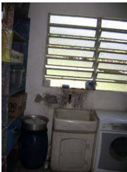
Imagem 1.4.4: Vista do interior da lavanderia. Fonte: Autora, 09/2010
