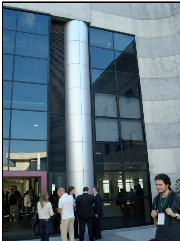
Figura 69 – Fachada de vidro
