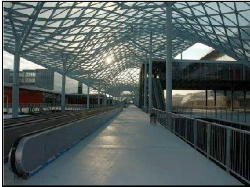
Figura 59 – Passarela de vidro (Arco web, 2008).
