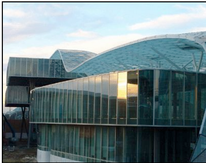
Figura 58 – Prédio da Feira Milano (Arco web, 2008).
