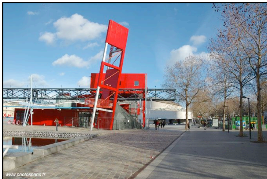
Figura 42- Passarela coberta e calçadão
