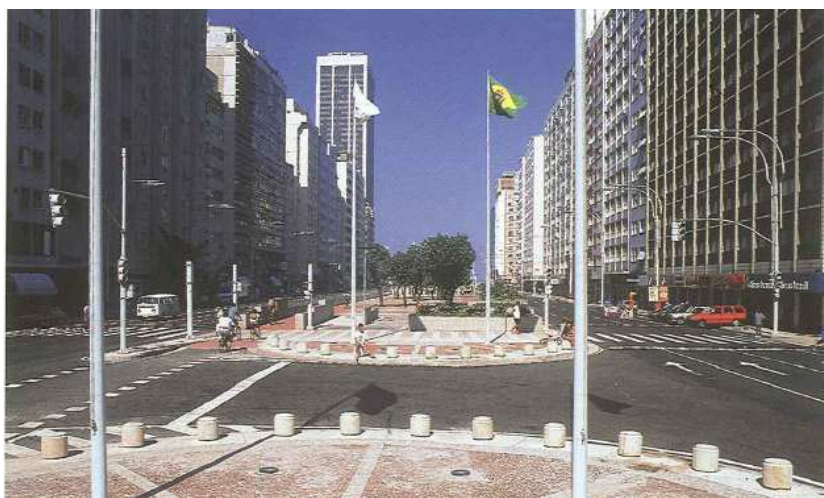
Imagem 5.34: Vista da Avenida em direção ao mar (PREFEITURA DO RIO DE JANEIRO, 1996).
