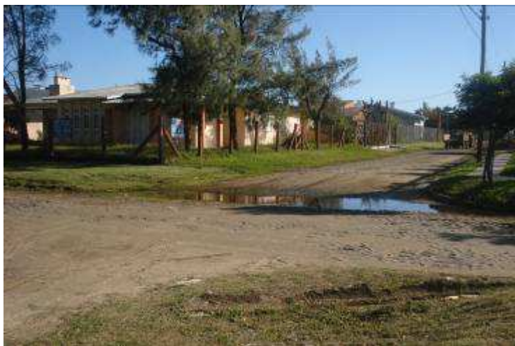
Imagem 1.6: Acúmulo de água da chuva no cruzamento das vias.
