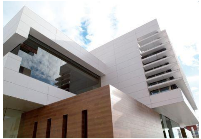
Figura 103 - Residência - Detalhe para a volumetria desencontrada, brises, bloco com vidro e vazado e revestimento de madeira. (Fonte: GOOGLE IMAGES, 2010)
