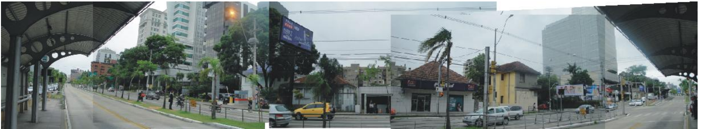
Figura 60 - Foto panorâmica Av. Carlos Gomes - vista para os lotes. (Fonte: AUTORA, 2010)
