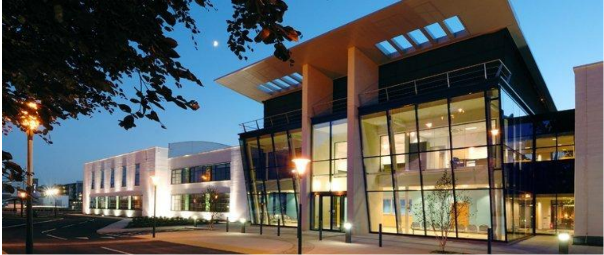
Figura 97 - Edificação Comercial - Destaque para fachada de vidro inclinada, sofisticação e elemento de cobertura - bloco em primeiro plano. (Fonte: FLICKR, 2010)
