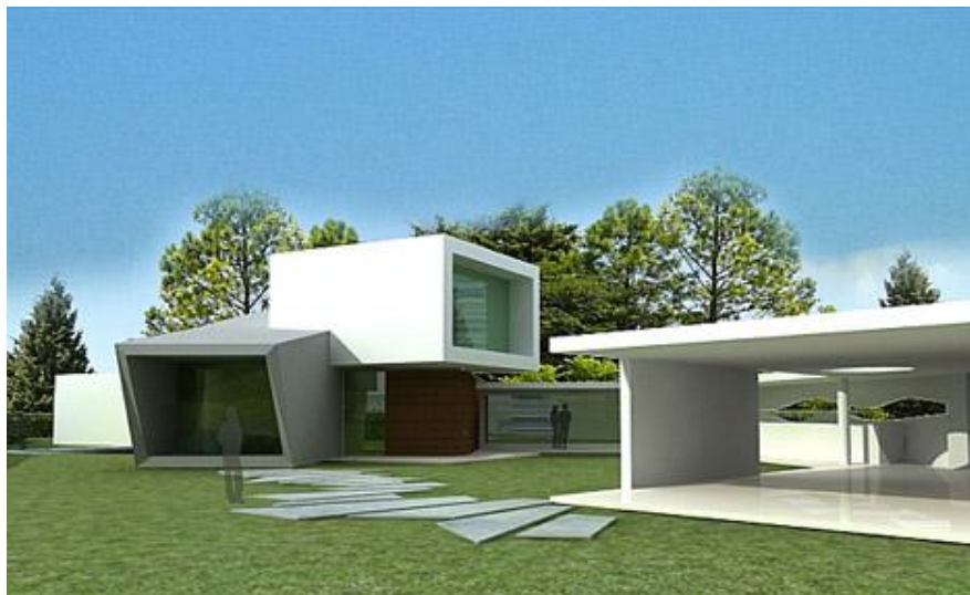
Figura 110 - Volumes residência e estacionamento - Casa Orquidea - Andrés Remy. (Fonte: ANDRES REMY ARQUITECTOS, 2010)
