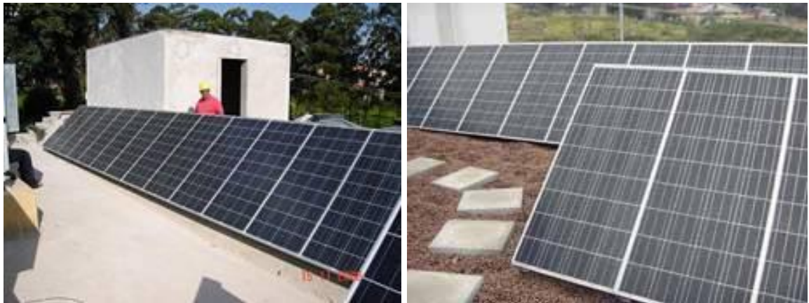
Figuras 72 e 73 - Painéis fotovoltaicos - cada um corresponde a uma lâmpada (Fontes: IDHEA e REVISTA INFRA, 2007)
