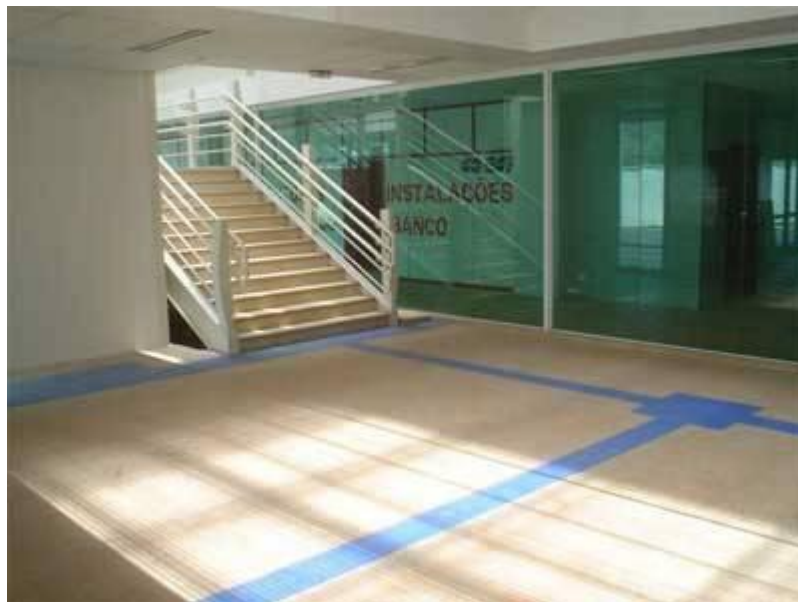
Figura 10 - Exemplo de piso tátil de alerta - Ambiente interno. (Fonte: GOOGLE IMAGES, 2010)
