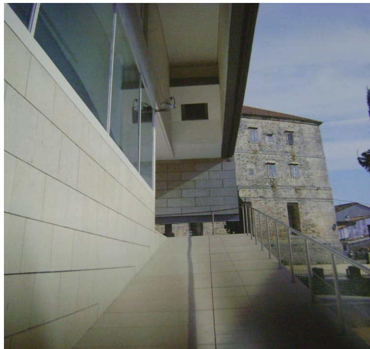
Figura 8.10. – Rampa de acesso principal do museu (TRIGUEIROS, 1995).
