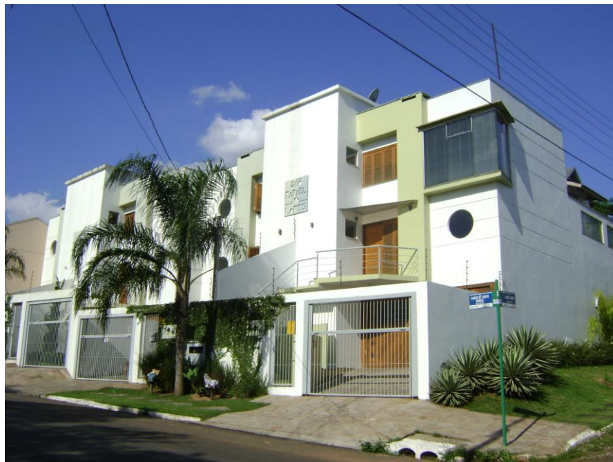
Figura 4.12. – Lofts na Rua Barão de Santo Ângelo
