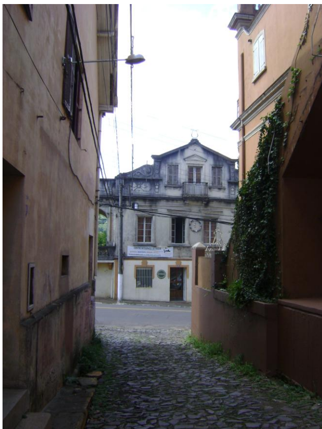
Figura 4.4. – Vista da Rua Almiro Lau no bairro de Hamburgo Velho
