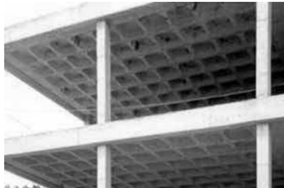
Figura 8.9: **Laje nervurada com vigas rígidas nas extremidades** (ATEX, apud, DIAS, 2010)
