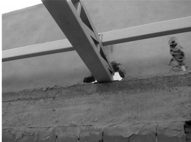
Figura 8.17: Apoio da tesoura à platibanda (DUARTE, 2009)
