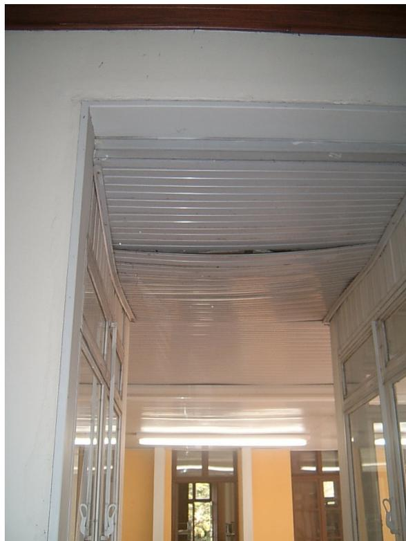
IMAGEM 34 – Forro abaulado pela infiltração. Fonte: AUTOR, 2011.
