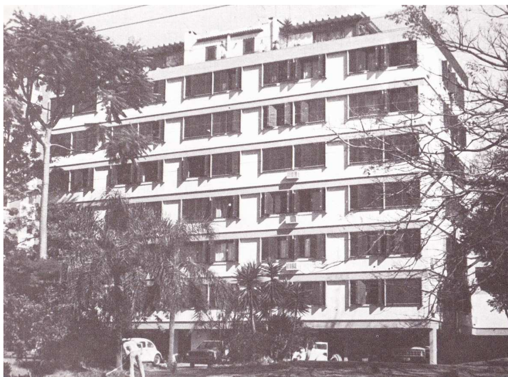
Figura 4 - Edifício Presidente/ 1970. (FONTE: XAVIER, 1987).
