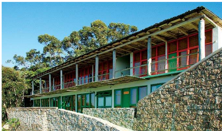
Imagem 5.4.3. Pousada Pedra Grande, (Arcoweb, 2009)
