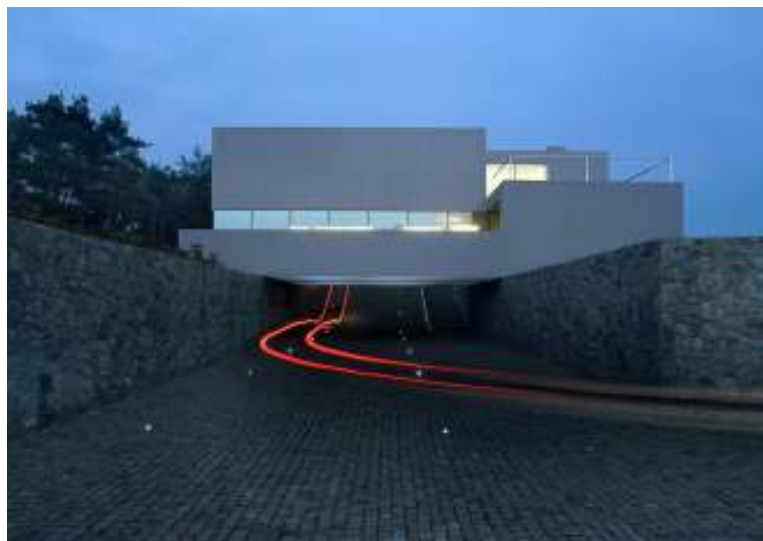
Imagem 72: Acesso de veículos e pedestres.
