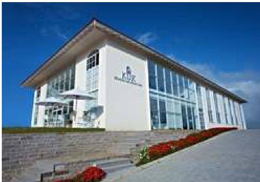
Imagem 39: Prédio estação das águas Kurotel.
