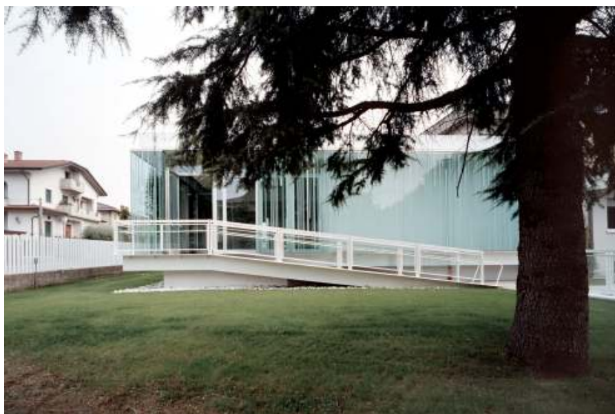
Imagem 70: Segunda rampa de acesso.
