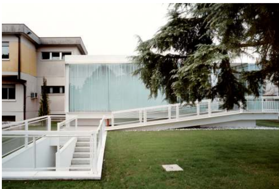
Imagem 71: Escada de acesso ao subsolo.
