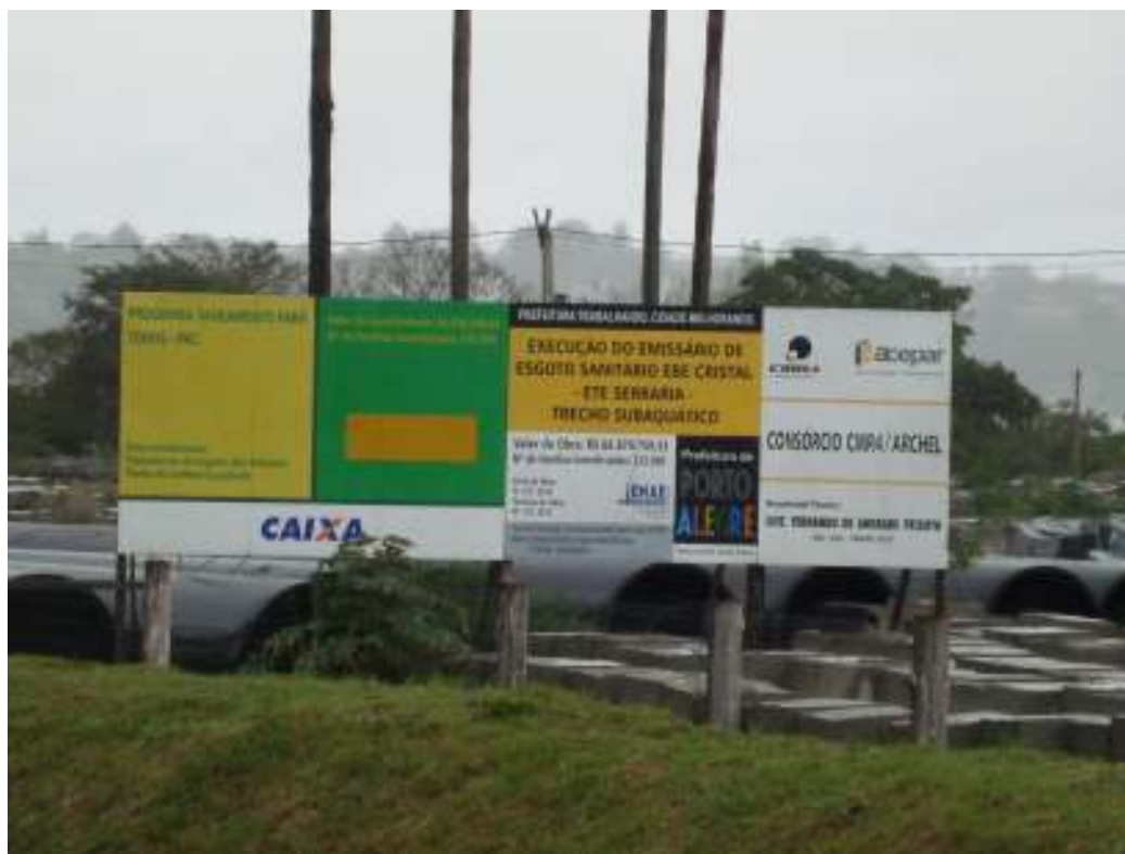
Imagem 20: Informações das obras de esgoto sanitário que estão sendo feitas com acesso pelo lote.
