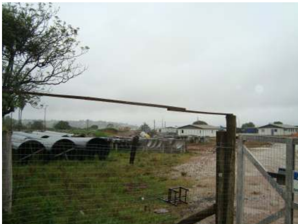
Imagem 21: Lote com edificações pré-existentes.
