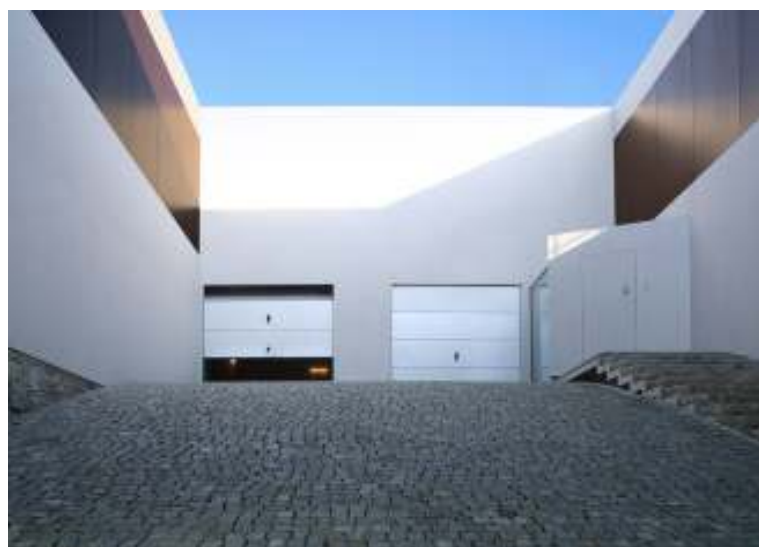
Imagem 73: Átrio central (acesso de veículos e pedestres).
