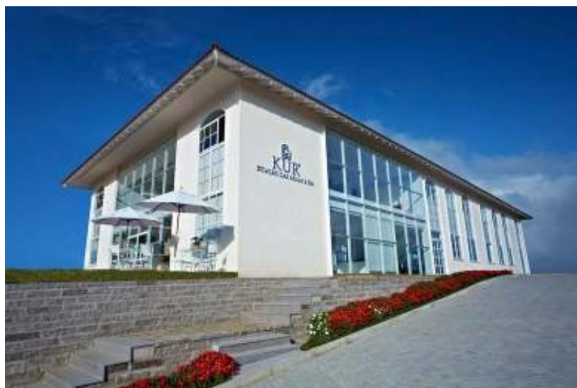
Imagem 22 – Foto do prédio do Day Spa – Estação das Águas. Fonte: KUROTTEL (2011)
