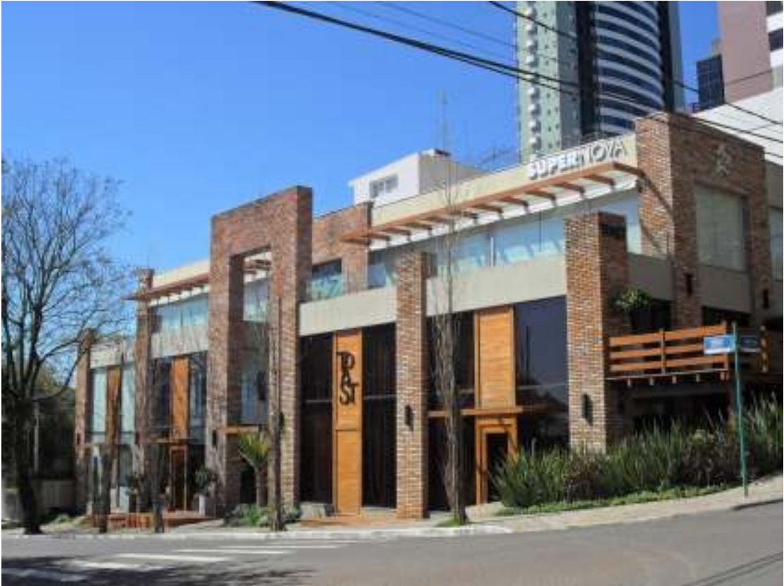
Imagem 45 – Foto do entorno próximo com uma edificação contemporânea para fins comerciais – Rua Augusto Jung. Fonte: autora (2011)
