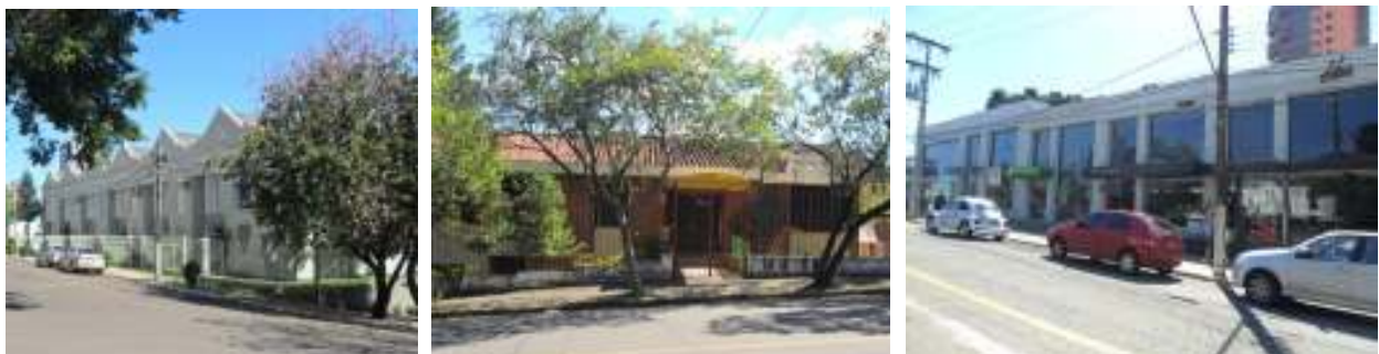
Imagens 42, 43 e 44 – Fotos das edificações do entorno próximo, mostrando as tipologias e os recuos de cada prédio – Rua João A. da Silveira. Fonte: autora (2011)
