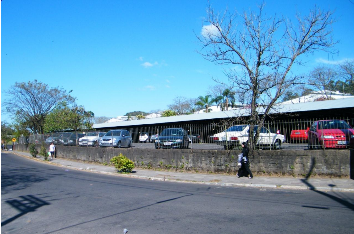
Figura 14: Vista norte do complexo industrial Vulcabrás|jazaléia FONTE: Autor, 2011.
