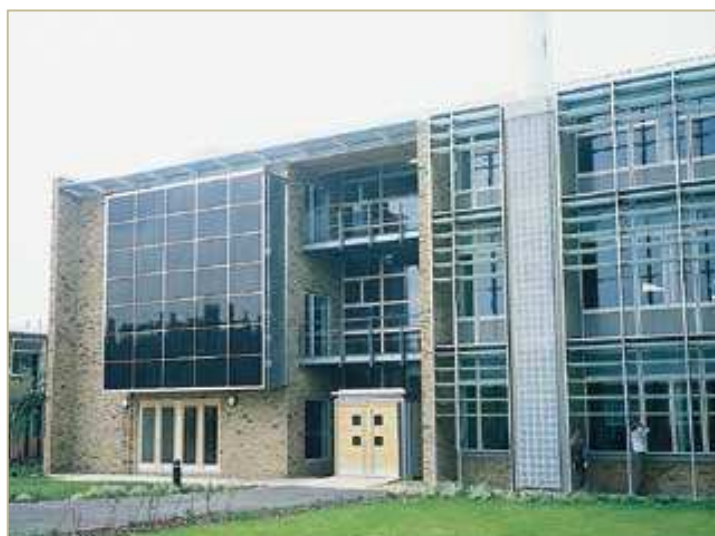
Figura 5.6: Painel fotovoltaico na sede do Building Research Energy, em Londres
