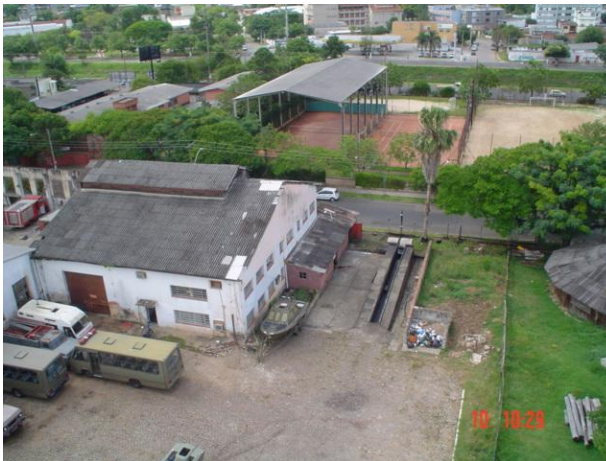
Figura 25 – Vista da Escola. (Fonte: KONARZEWSKI, 2010)
