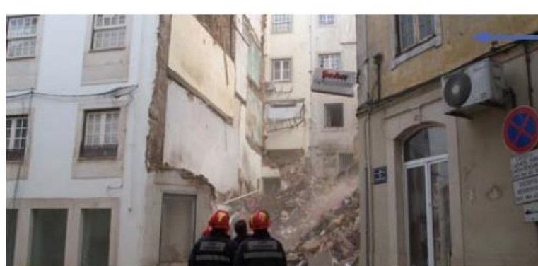
Figura 69 – Queda de estrutura. (Fonte: GOOGLE,2011)
