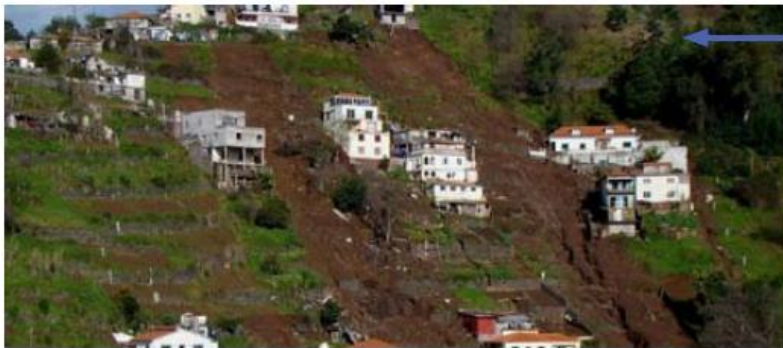
Figura 71 – Deslizamentos. (Fonte: GOOGLE,2011)
