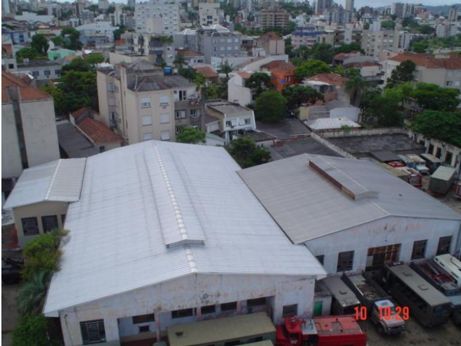
Figura 27 – Vista Da Escola em alguns edifícios. (Fonte: KONARZEWSKI, 2010)
