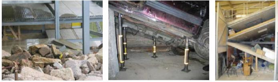
Figura 73 – Aulas de em estrutura em colapso. (Fonte: GOOGLE,2011)
