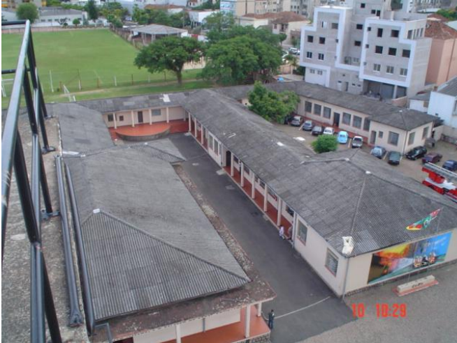
Figura 30 – Vista da Escola de Bombeiros. (Fonte: KONARZEWSKI, 2010)
