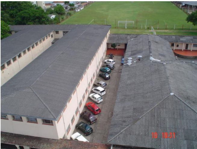
Figura 31 – Vista da Escola de Bombeiros. (Fonte: KONARZEWSKI, 2010)
