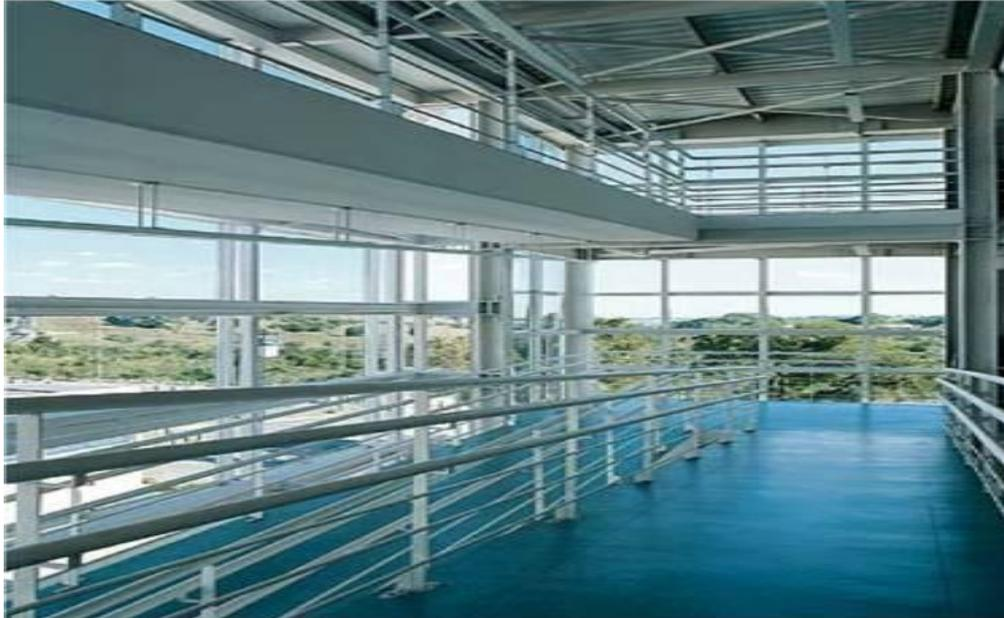
**Imagem 8.8 - Estruturas e corrimãos metálicos, elementos pré-moldados de concreto, agilizaram a montagem. Fonte: (web site Arco Web, 2011).**
