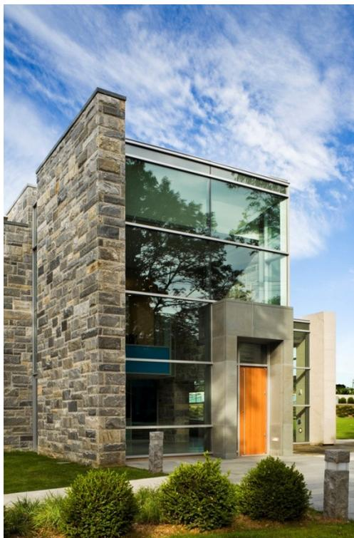
**Imagem 4.18 - Revestimentos de pedra natural, concreto aparente e vidro.**
