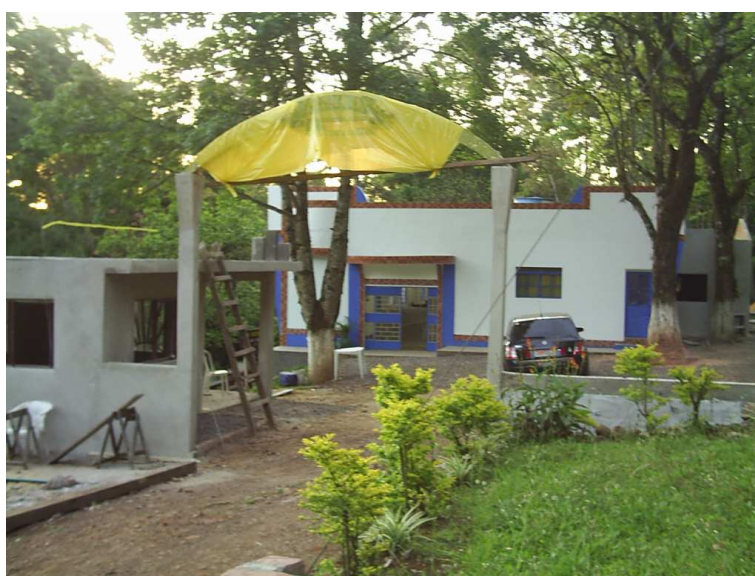
Figura 2.3: Novas edificações em construção
