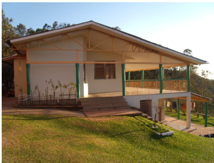
Figura 2.17: Edifício onde se encontra a cozinha, refeitório, espaço também para os encontros de famílias, e, abaixo, alojamento dos monitores
