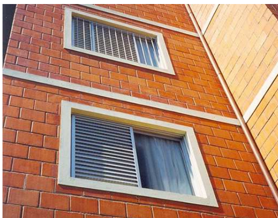
Figura 7.3: Paredes com vedação de blocos cerâmicos (AECWEB, 2011)
