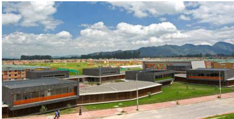
Figura 5.22: Composição das edificações. (PLATAFORMA ARQUITETURA, 2011)
