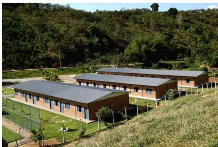
Figura 5.13: Vista geral das instalações (VEM VIVER, 2011)
