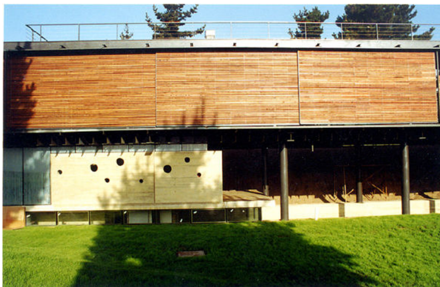
Imagem 101 – Painéis móveis de madeira na fachada (CASA 75, 2008).
