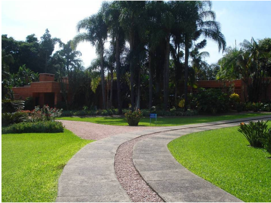
Imagem 78 – Edificação inserida em meio à natureza.
