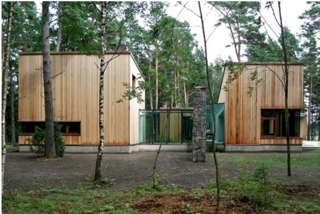
Imagem 102 – Painéis móveis de madeira na fachada (VILA ISABELLA, 2008).
