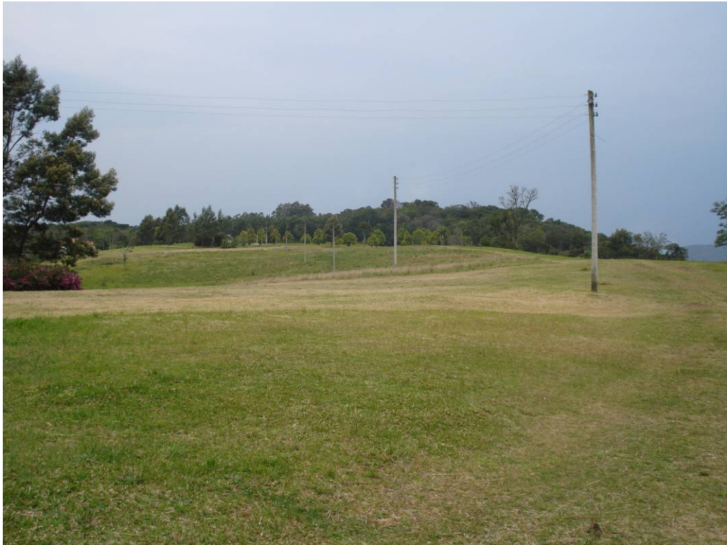
Vista do lote com presença de taludes.
