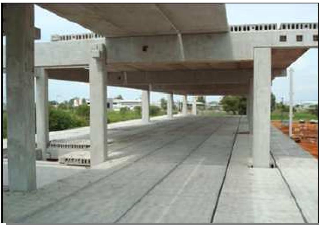
Figura 44: Lajes alveolares concreto. (PRECONCRETOS, 2009).
