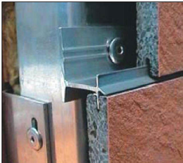
Figura 48: Detalhe de junta de placas compósitas de Polímero (WORDPRESS, 2006).
