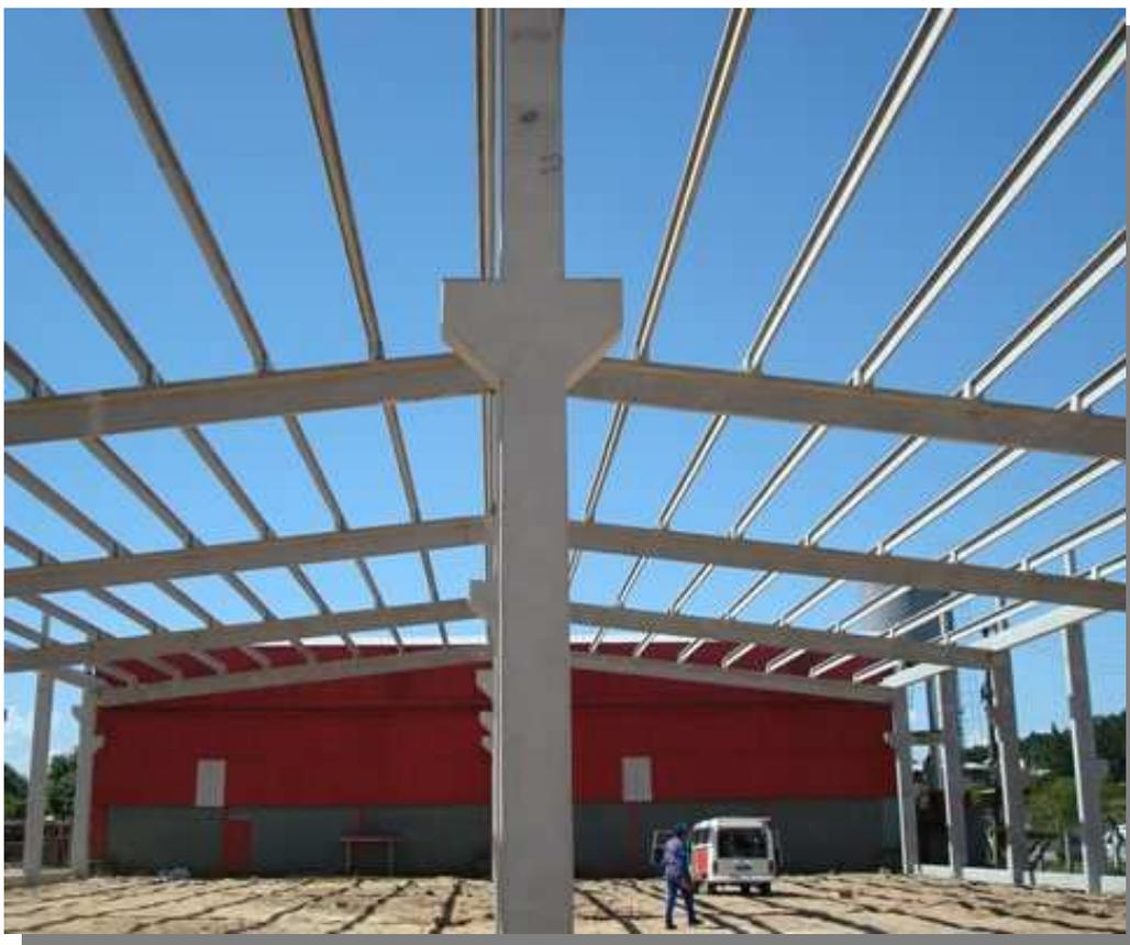
Figura 46: Cobertura em concreto protendido. (PRECONCRETOS, 2009).
