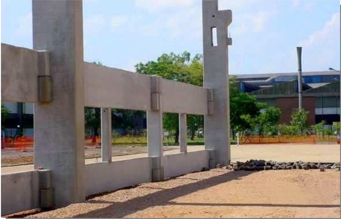
Figura 45: Painéis de fachadas Preconcreto. (PRECONCRETOS, 2009).
