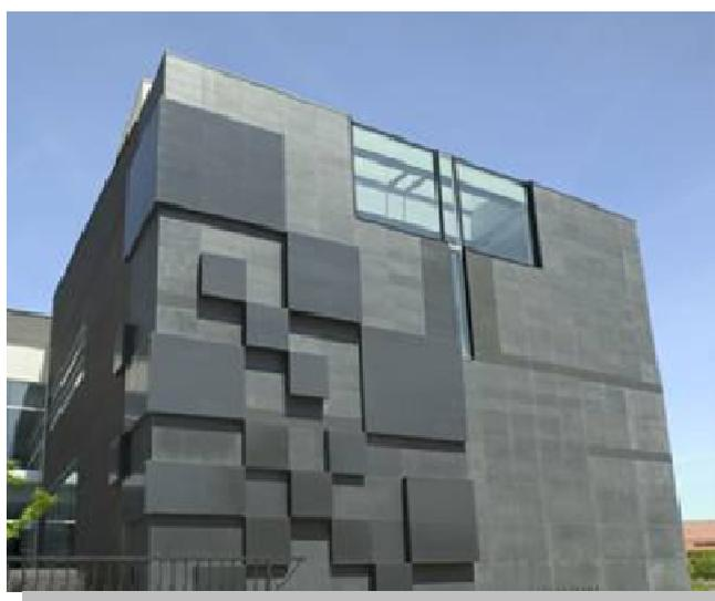
Figura 49: Edifício com sistema de fachada ventilada (WORDPRESS, 2006)
