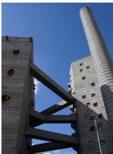
Figura 27 - Vista externa do edifício
