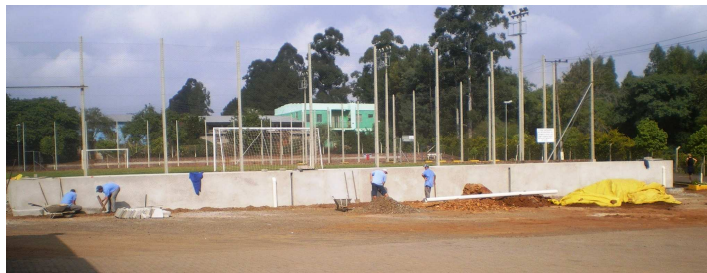
Imagem 21 – Construção das 03 cisternas Fonte: AUTORA, 2012
