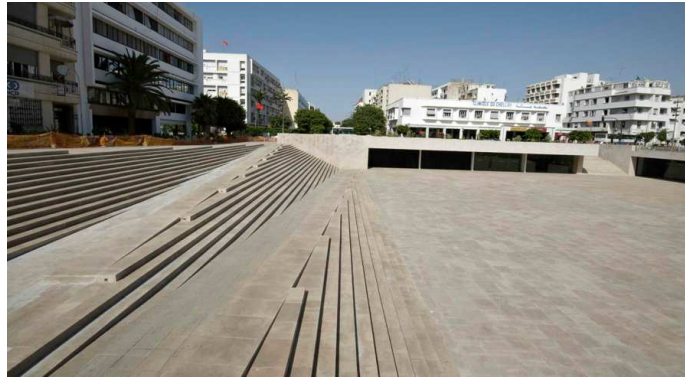
Imagem 72 – Vista interna da praça
