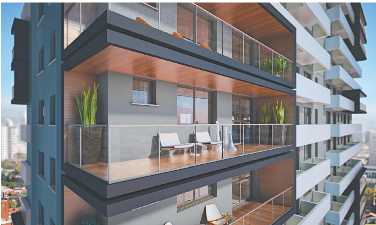
Figura 32 Sacada da torre residencial.
