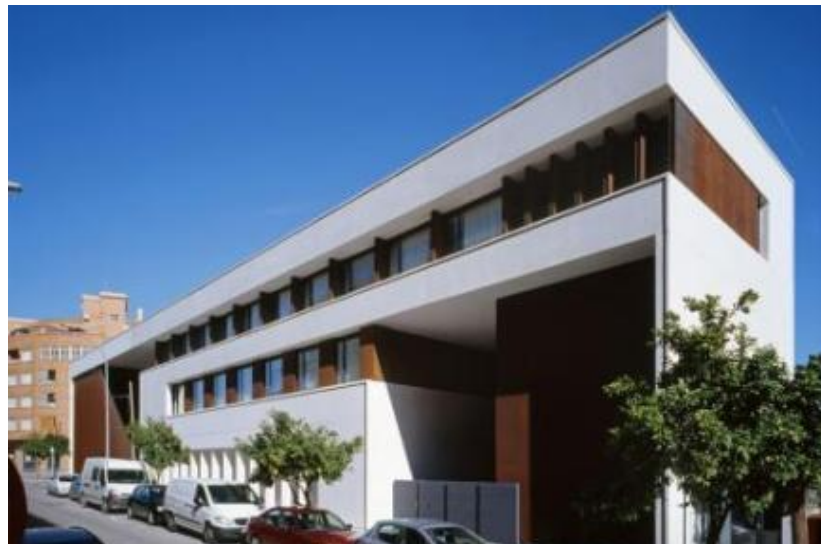
Imagem 30: Fachada frontal da Residencia Tercera Edad. Fonte: PENIN (2009).
