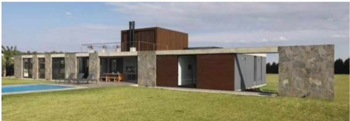
Imagem 24: Fachada perspectivada da edificação. Fonte: BENITO (2008).
