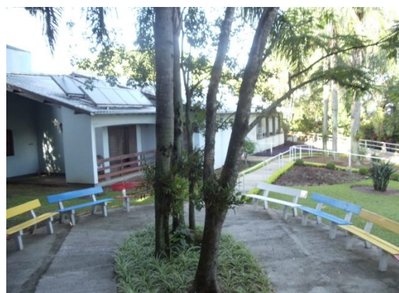
Imagem 47: Vista da edificação Fonte: Autora 2012
