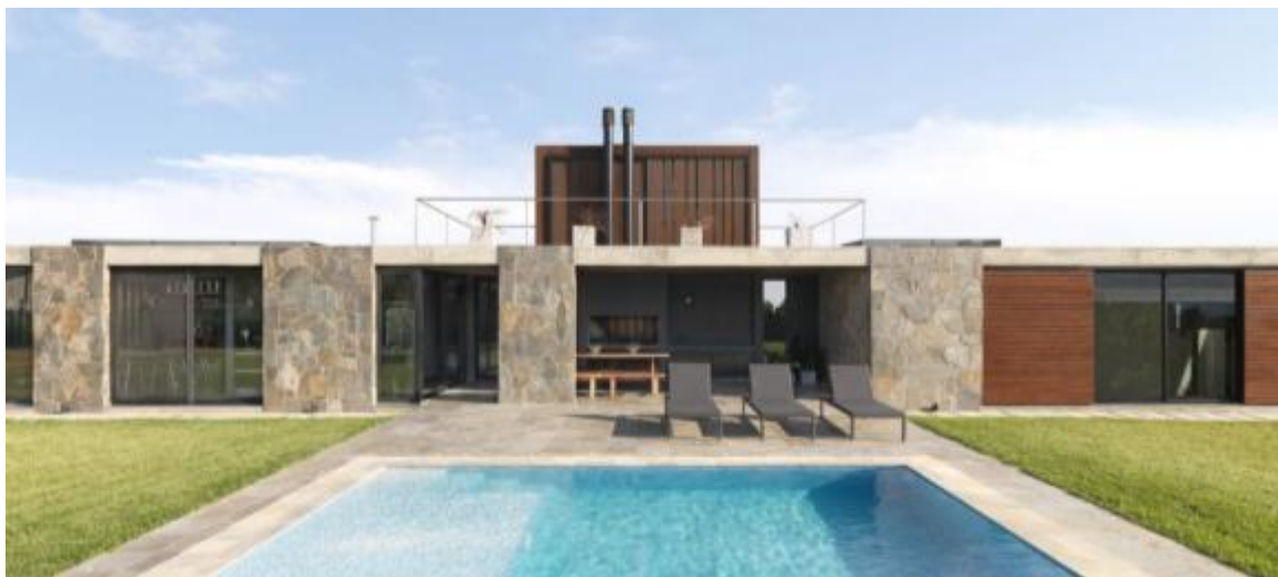
Imagem 26: Fachada frontal da edificação. Fonte: BENITO (2008).
