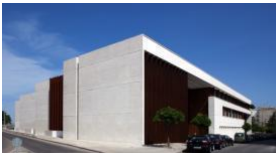
Imagem 31: Fachada lateral e frontal Fonte: PENIN (2009).
