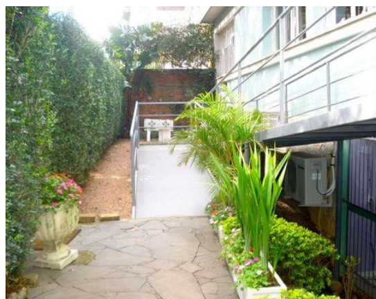
Imagem 53: Rampa externa de acesso, Fonte: GOMES, Sílvia (2012).
