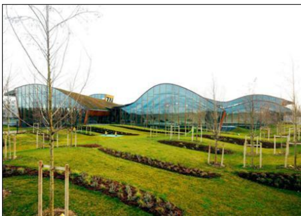
Figura 77 – Jardim e Cobertura do Centro Fonte: FREARSON, 2012
