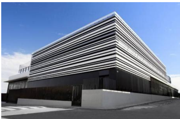
Figura 56 – Lâminas de Alumínio na Fachada Fonte: HELM, 2012
