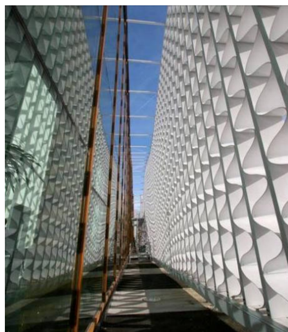
Figura 81 –Conexão da Fachada e Muxarabis Fonte: FREARSON, 2012
