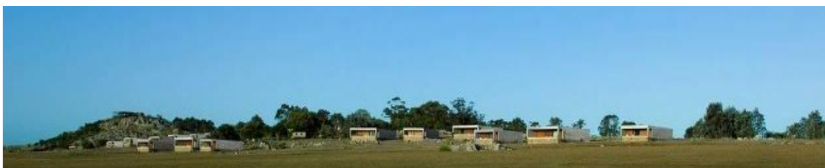
Figura 102 - Vista Geral do Hotel Fonte: KING, 2012
