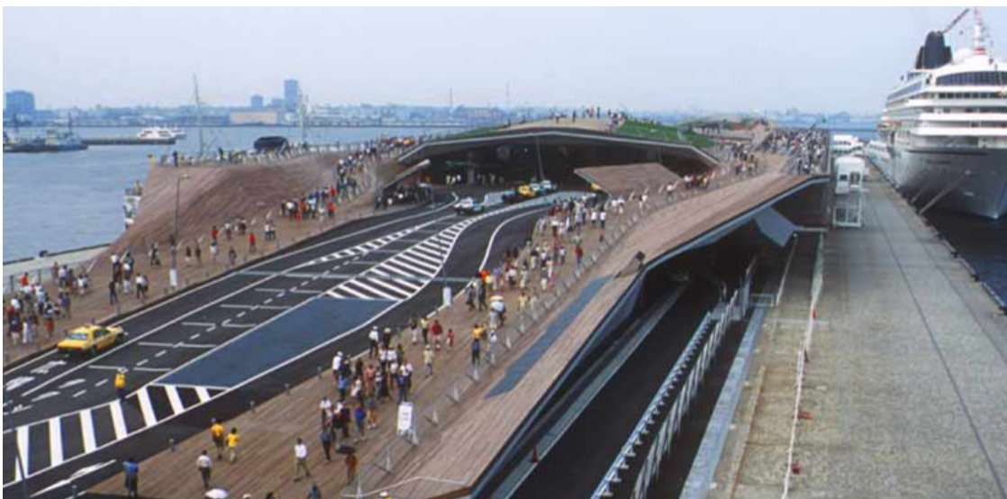
Figura 50: Yokohama Terminal, cobertura também é espaço de transição, passagem, vistas.
