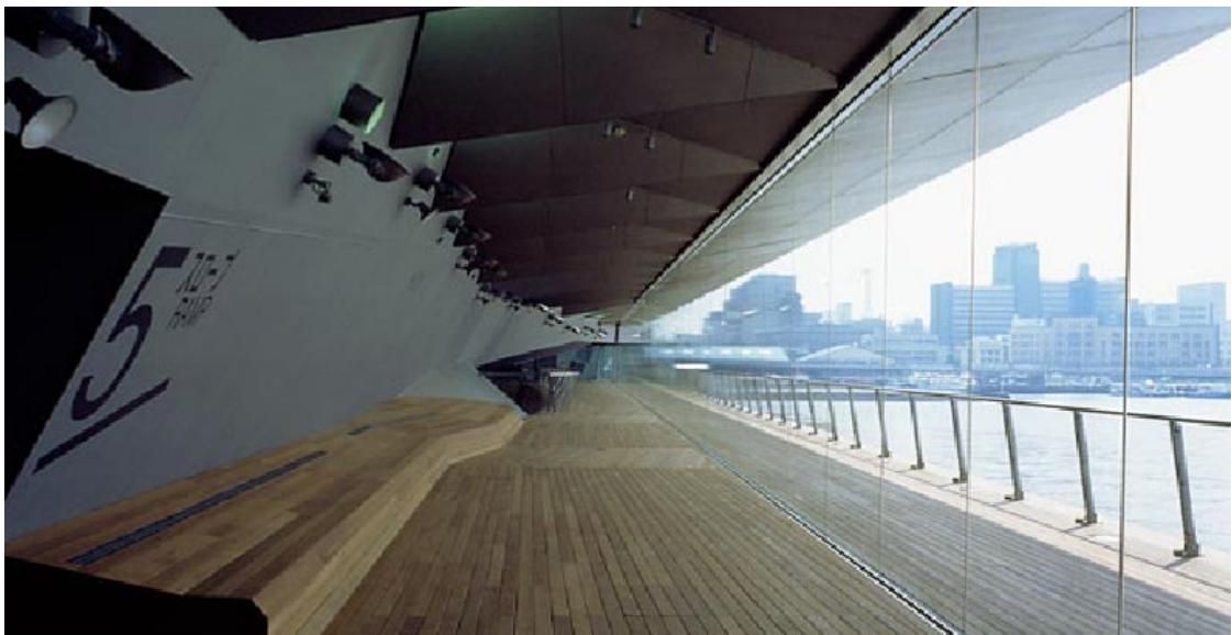
Figura 51, 52 e 53: Destaque para a cobertura e transição exterior e interior.
