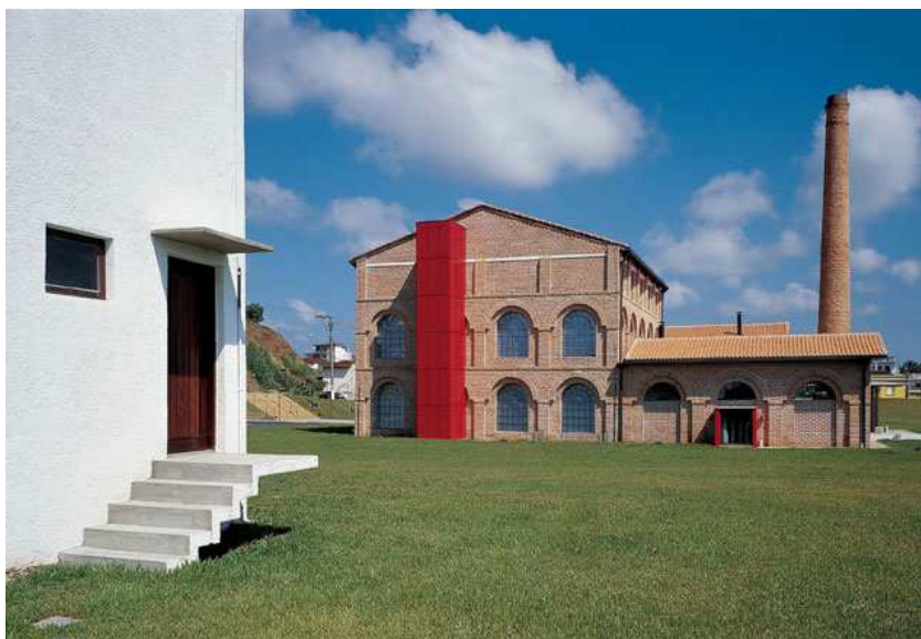
Imagem 87: Ao fundo elevador na edificação antiga, à frente, o Teatro
