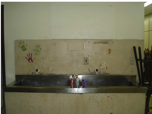
Imagem 78: Pias nos corredores
