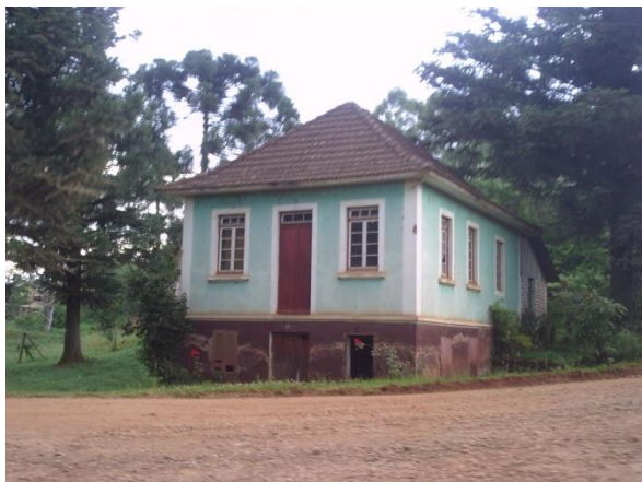
Imagem 20 – Residência de alvenaria em estado de conservação regular. (Fonte: autora, 2012)
