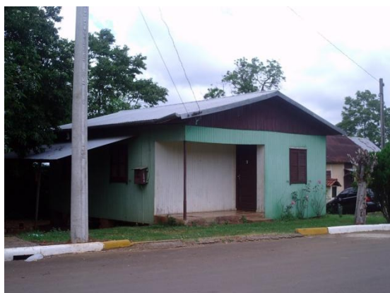
Imagem 23 – Residência de madeira em estado de conservação regular. (Fonte: autora, 2012)
