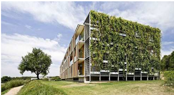
Imagem 95: Fachada de um dos blocos, com as fachadas protegidas com brises naturais. Fonte: PLATAFORMA ARQUITECTURA, 2012.
