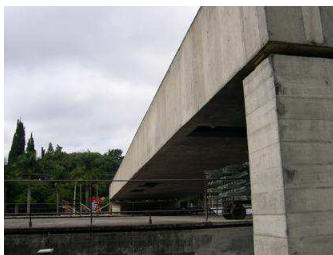
Imagens 129 e 130: Painel pré-moldado alveolar, e detalhe da fachada pré-moldada do MUBE (Museu Brasileiro da Escultura). Fonte: PINIWEB, 2003.
