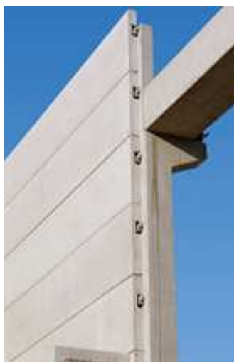
Imagens 129 e 130: Painel pré-moldado alveolar, e detalhe da fachada pré-moldada do MUBE (Museu Brasileiro da Escultura). Fonte: PINIWEB, 2003.
