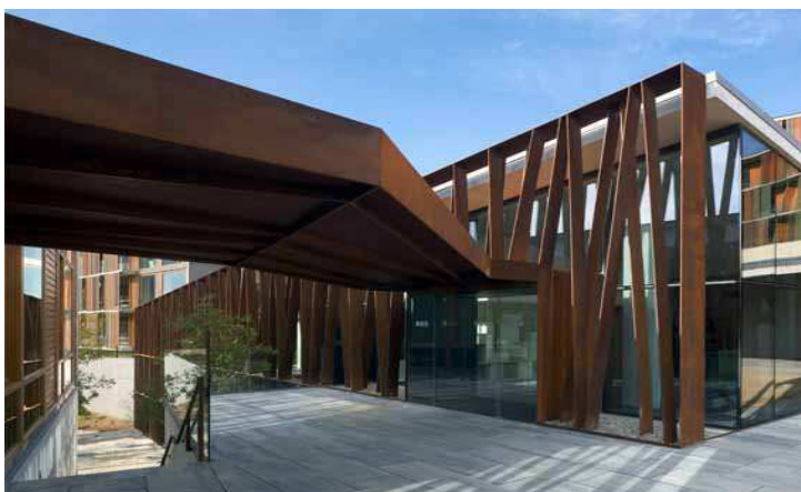
Imagem 97: Bloco central com fachada principal envidraça e protegidas com brises solares fixos. Fonte: PLATAFORMA ARQUITECTURA, 2012.
