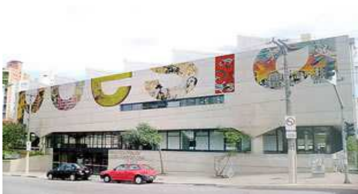
Imagem 105: Fachada Principal da biblioteca. Fonte: ARCOWEB, 2012
