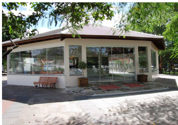
Imagem 17: Fachada Sul e acesso de entrada principal. Fonte: AUTORA, 2012.
