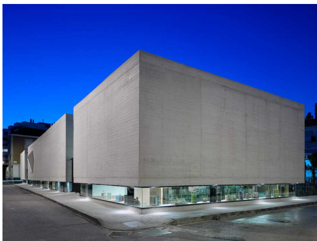
Imagem 118: Vista da fachada Sul. Fonte: PLATAFORMA ARQUITECTURA, 2012.
