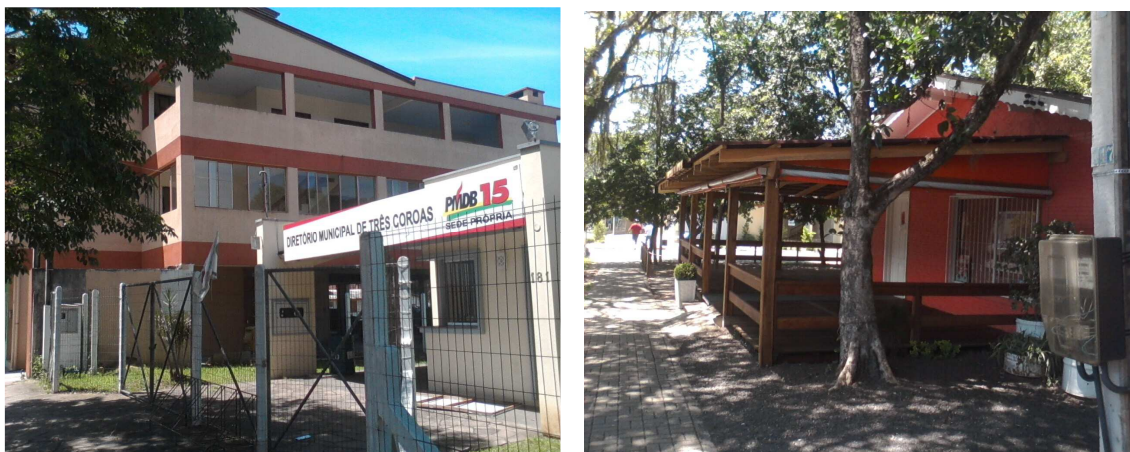
Imagens 65 e 66: Vistas da quadra pela Rua Tristão Monteiro, com as edificações existentes.
