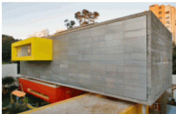
Imagem 102: Vistas dos blocos nas cores laranja e amarelo. Fonte: ARCOWEB, 2008.
