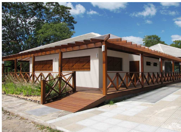
Imagem 18: Vista da Fachada Norte e Oeste. Fonte: AUTORA, 2012.
