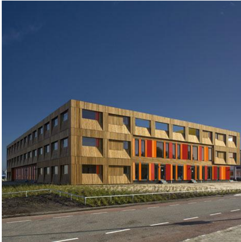
Figura 61 Vista externa da escola Fonte: HVDN Architecten disponível em www.deezen.com (2012) Foto: John Lewis Marshall
