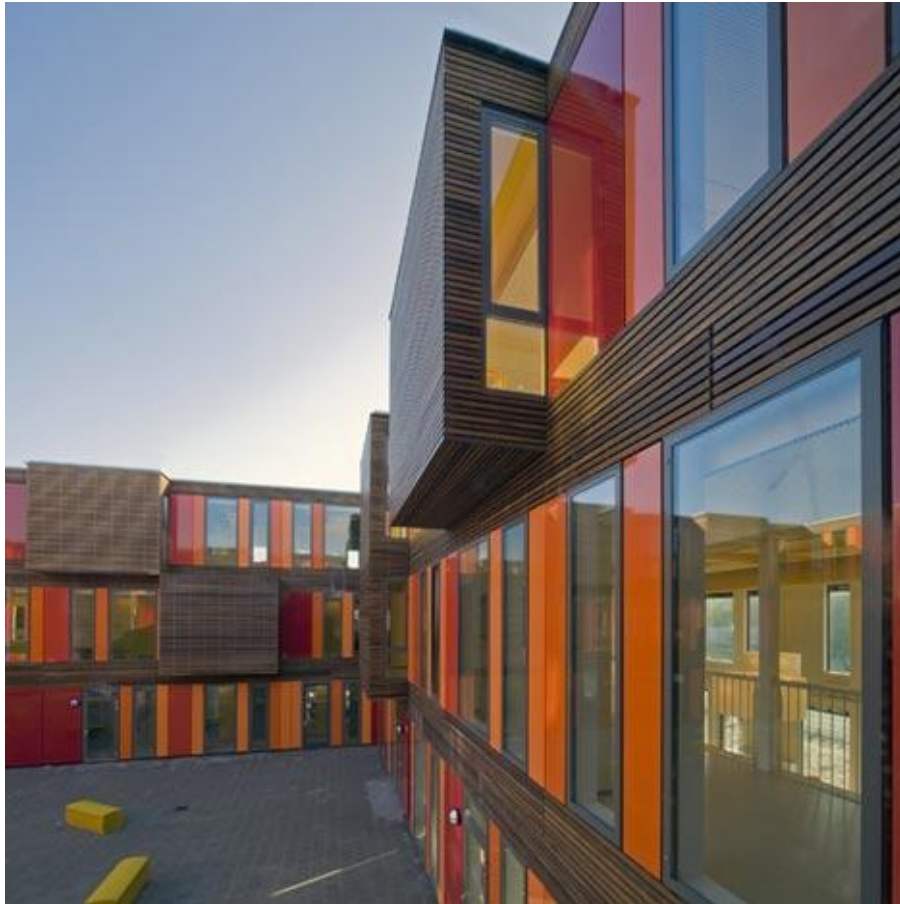
Figura 60 - Estrutura modular em madeira e alumínio Fonte: HVDN Architecten disponível em www.deezen.com (2012) Foto: John Lewis Marshall
