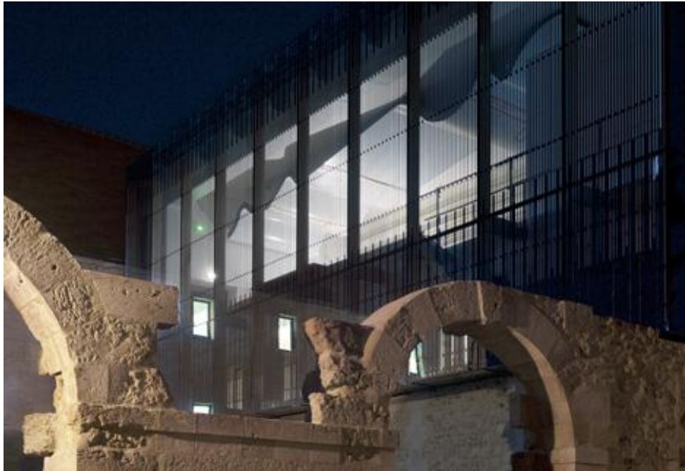
Figura 30 - Inserção arquitetônica Fonte: Opus 5 disponível em www.deezen.com (2012)
