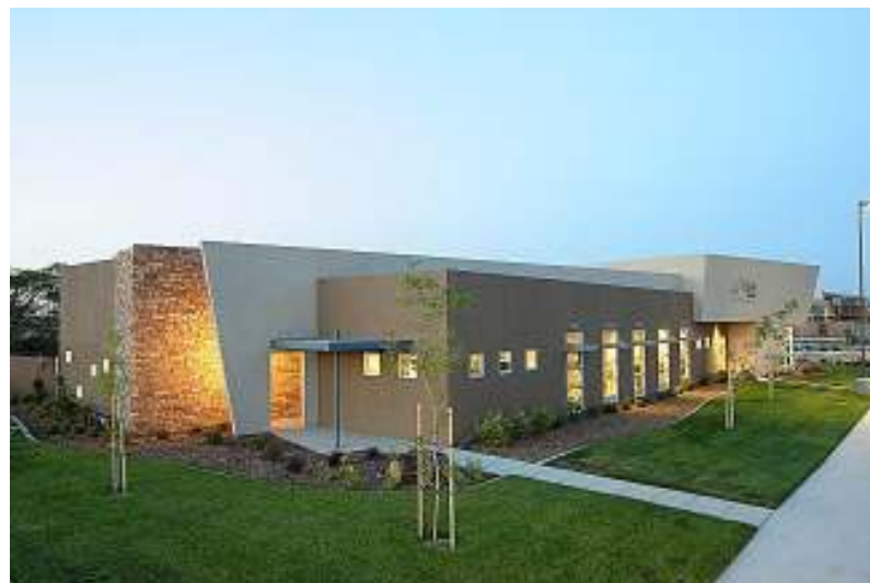
Figura 103 Vista posterior da edificação identificando uma segunda entrada Fonte: YELLOWBOT (2008)
