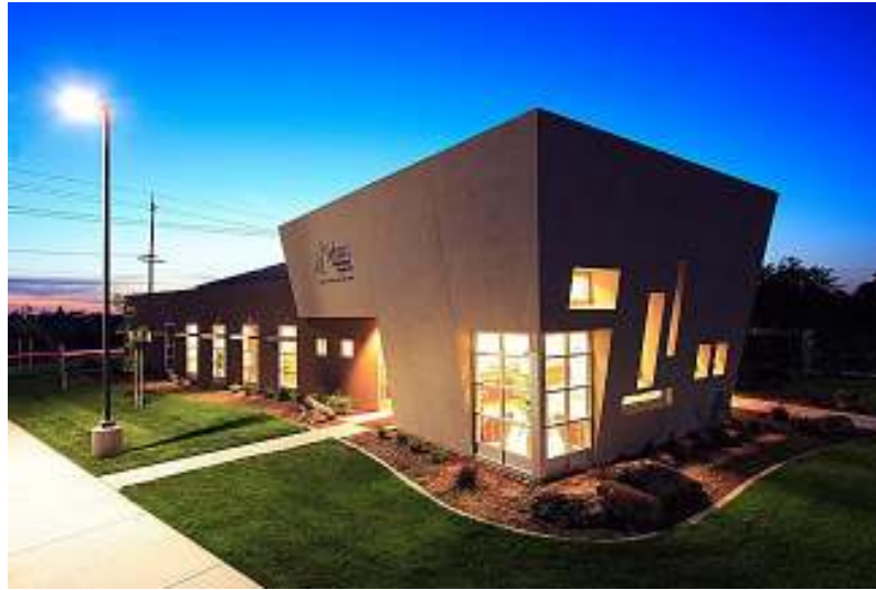
Figura 102 Vista frontal a edificação salientando a transparência através dos vidros Fonte: YELLOWBOT (2008)
