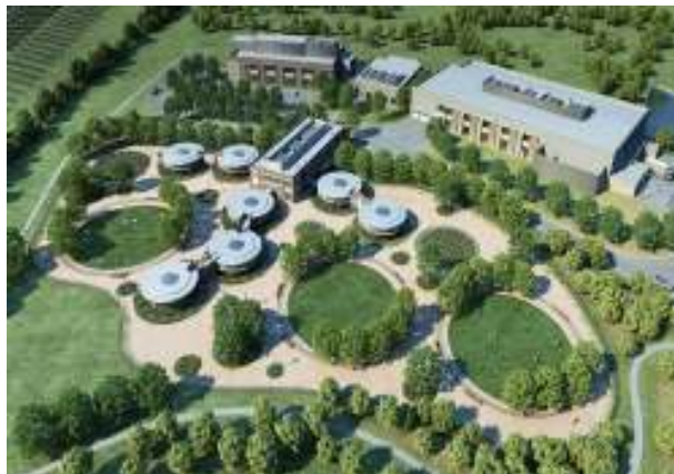
Figura 99 Vista aérea da empresa Mars Petcare EUA com a localização das edificações que interligam-se
