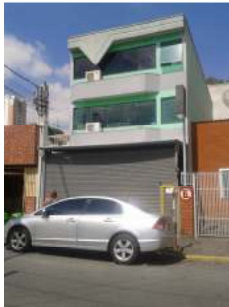
Figura 61 Prédio de ampliação do Hospital Fonte: AUTORA (2012)
