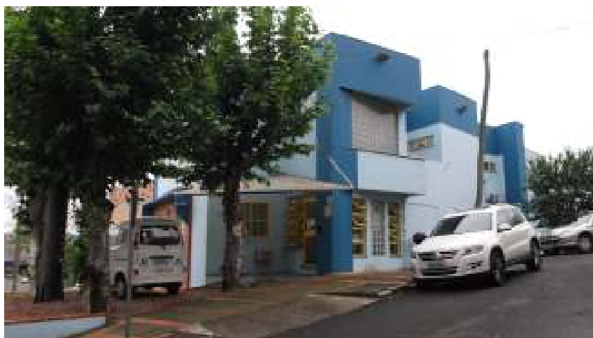
Figura 35 Fachada Sudeste do Hospital Veterinário de Novo Hamburgo Fonte: AUTORA, (2012)
