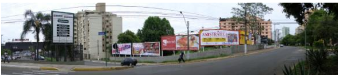
Figura 6 – Vista do lote à direita e do Hipermercado Bourbon à esquerda, a partir da Avenida Primeiro de Março
