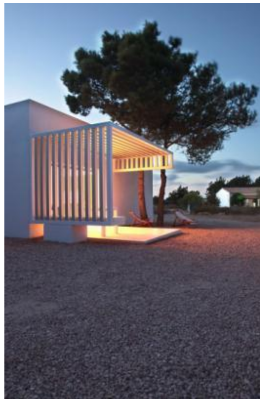
Figura 36 – Elemento diferenciado na entrada da Casa 8x8 Fonte: Arkinetia, 2005
