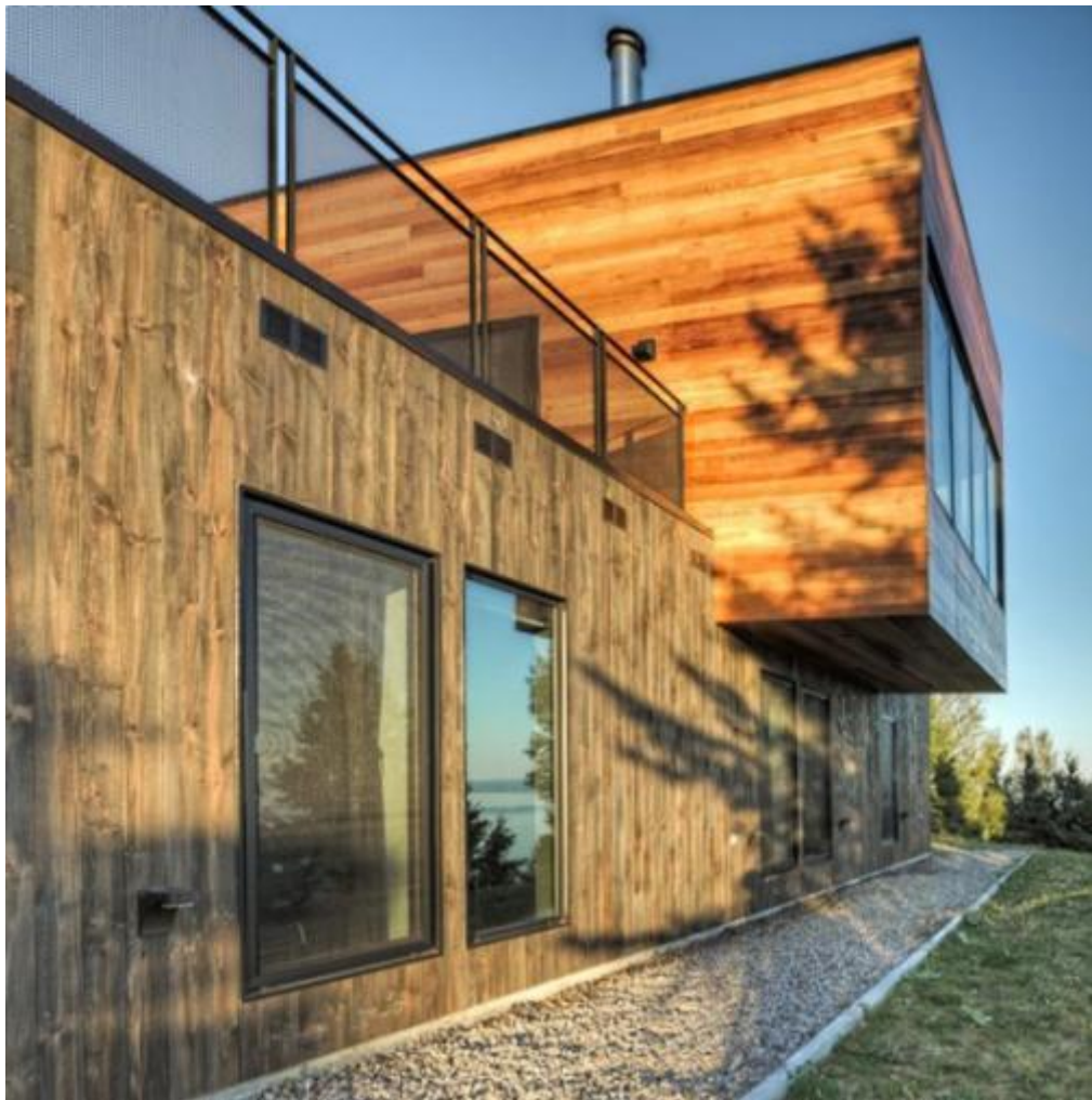
Figura 30 – Projeção de volume em balanço na Malbaie Residência em Quebec, Canadá Fonte: knstrct, 2011
