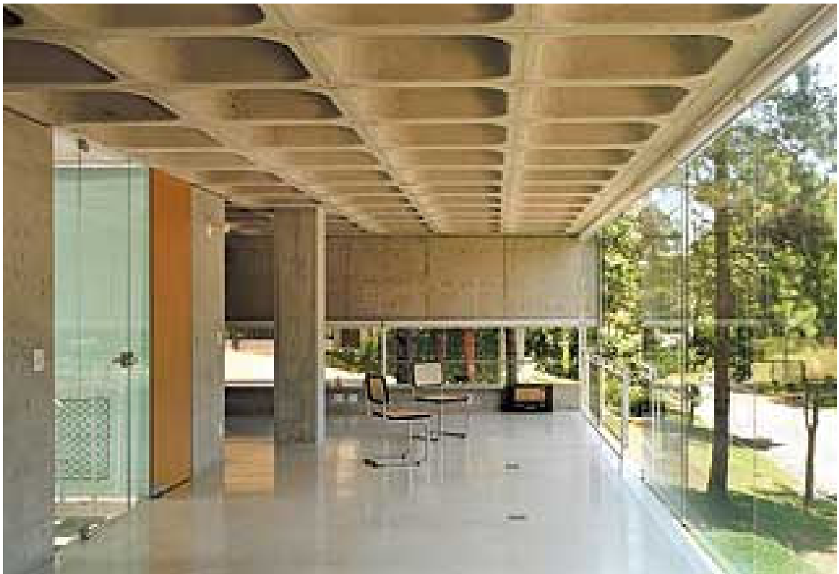
Imagem 5- Grande vão envidraçado com auxílio de laje nervurada Fonte: ARCOWEB, (2012).
