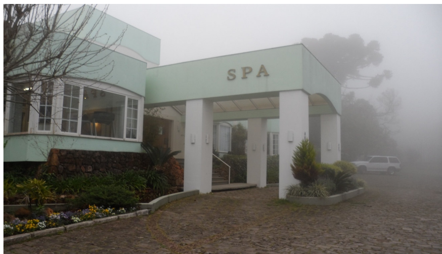
Imagem 36 – Acesso principal do SPA Laje de Pedra Fonte: Autora, 2012
