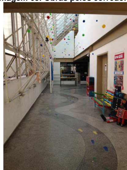
Imagem 68: Obras pelos corredores
