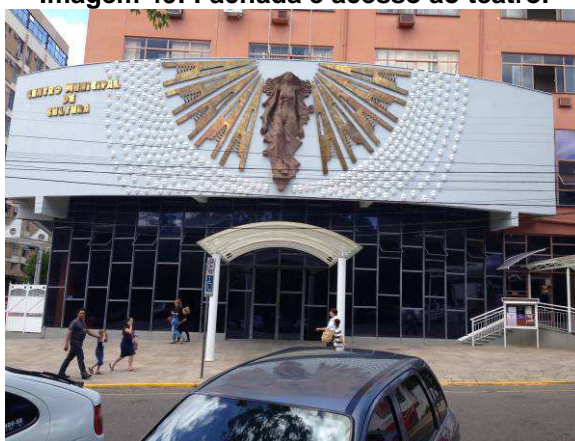
Imagem 49: Fachada e acesso ao teatro.
