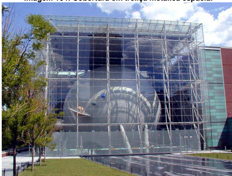
Imagem 104: Cobertura em treliça metálica espacial
