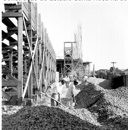
Imagem 26: Construção do Estádio Santa Rosa na década de 50.
