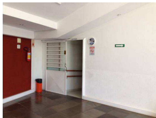
Imagem 53: Acesso aos sanitários e Prédio
