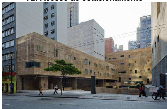
72: Acesso ao estacionamento
