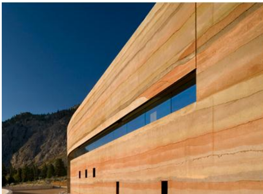
Figura 64 – Parede de Taipa mecanizada. Nk'Mip Desert Cultural Centre. Colúmbia Britânica, Canadá. HBBH
