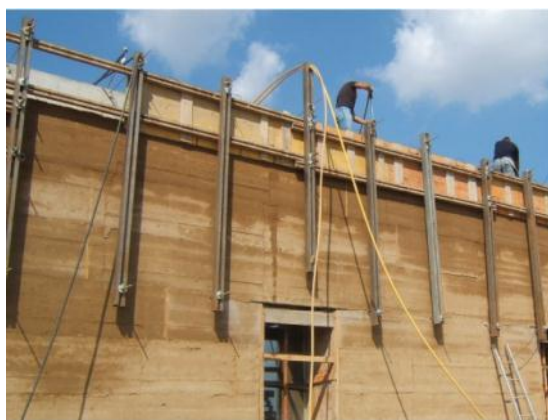
Figura 65 - Construção em Taipa mecanizada
